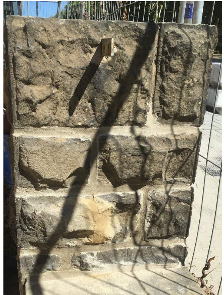
sowie Anwendung von Anböschmörtel nach Hintefüllung ...
