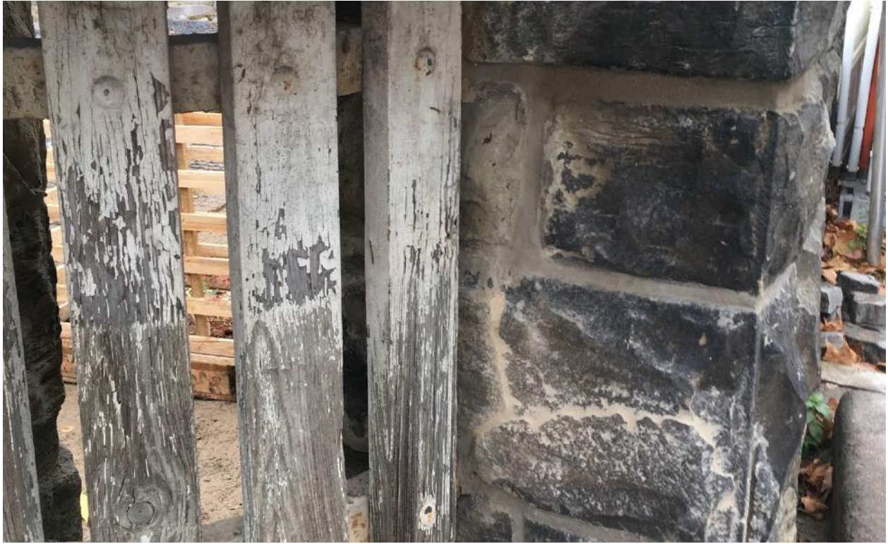
nach erfolgter Risseverpressung
