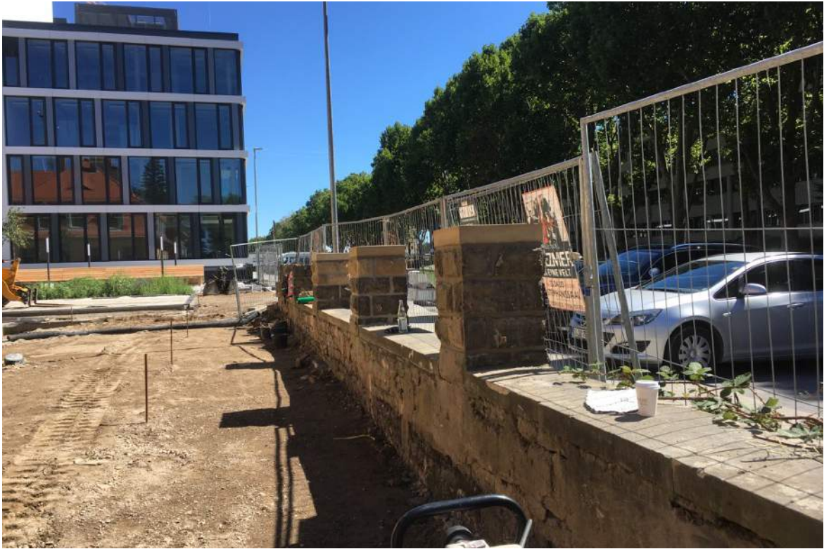
Ergänzte Fehlstellen mit Werksteinen und Abdeckungen
