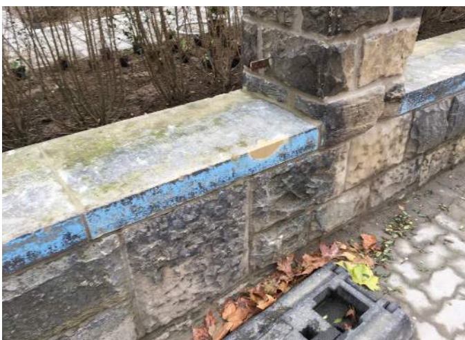
Reprofilierung mit Restauriermörtel
