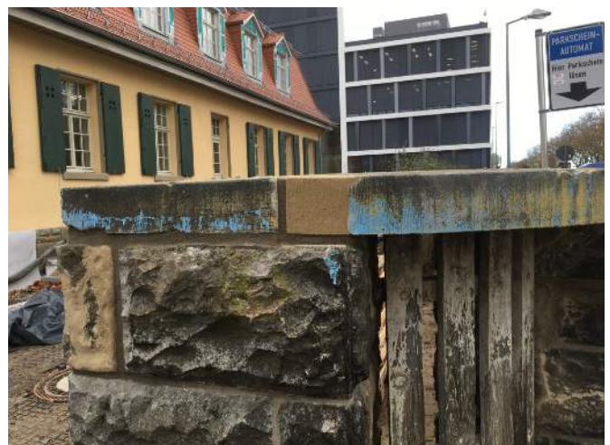
Ergänzung im Antrageverfahren mit Restauriermörtel
