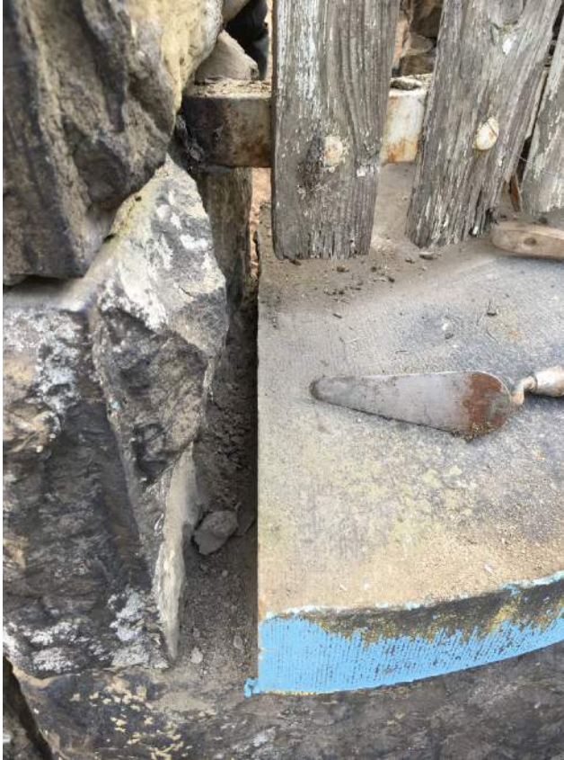
Ausbau der geschweiften Abdeckplatte TP West
