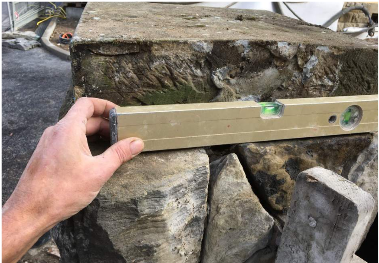
Ausrichten des Unterbaus
