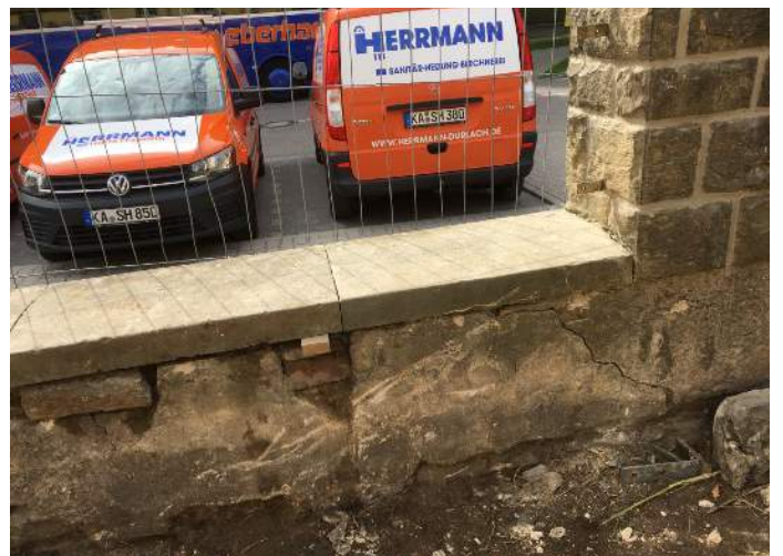
Im Mörtelbett verlegte und ausgefugte Abdeckungen
