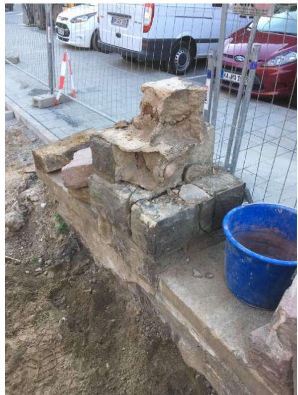
während dem Rückbau ...
