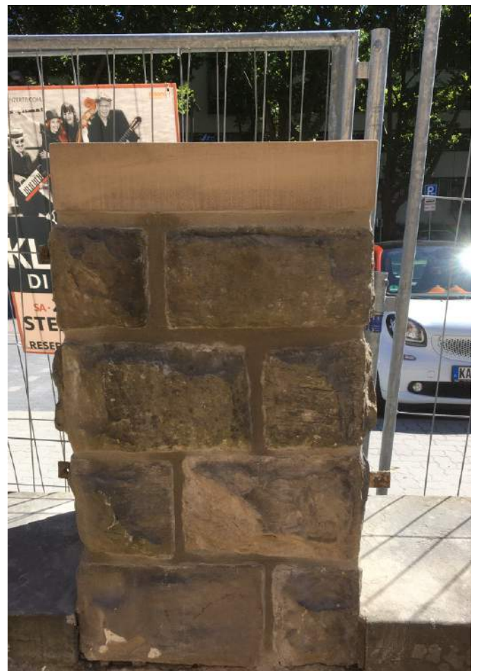
als Anböschmörtel und Hinterfüllung von Schalenbildungen
