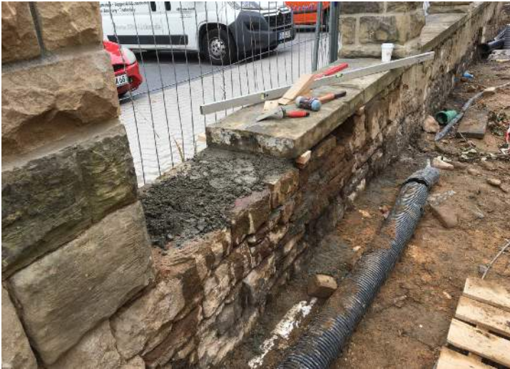
Verlegen der Mauerwerksabdeckungen in Trasskalkmörtel
