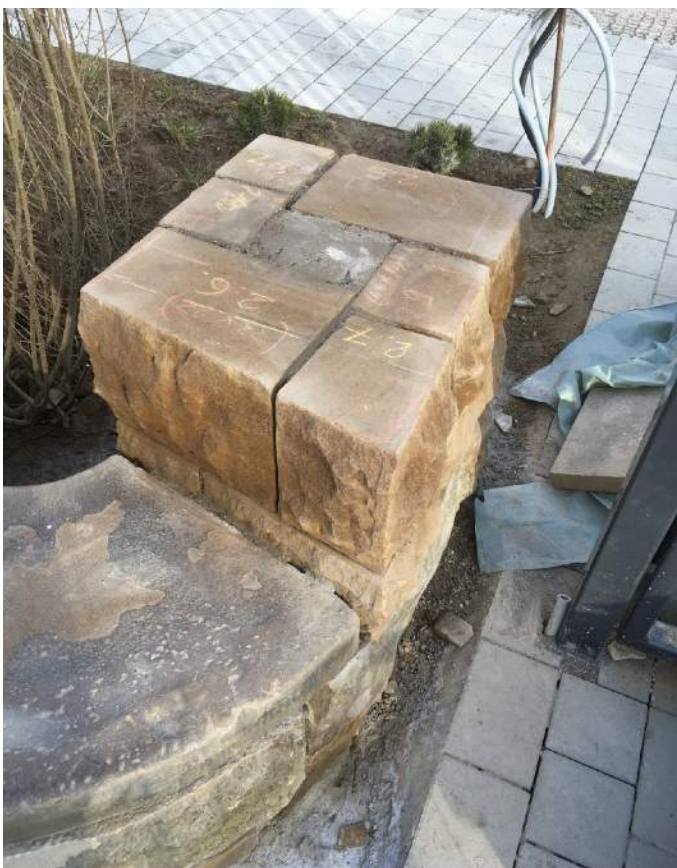
Aufbau des östlichen Mauerabschlusses
