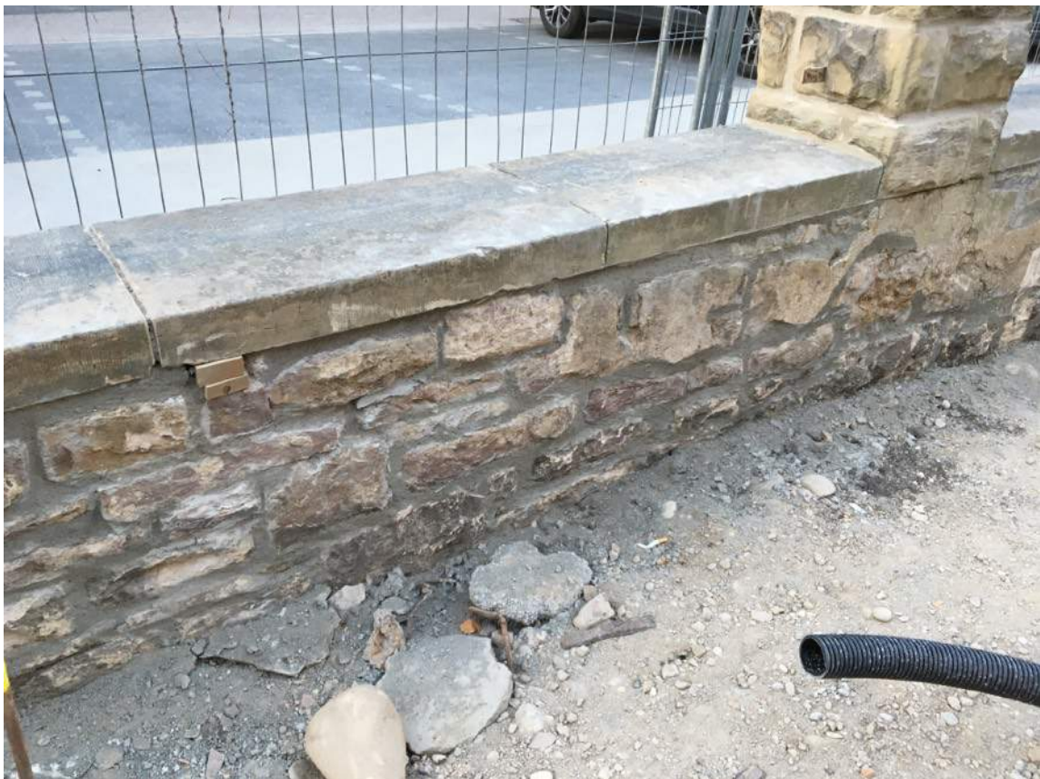
...nach Abschluss der Fugarbeiten ....
