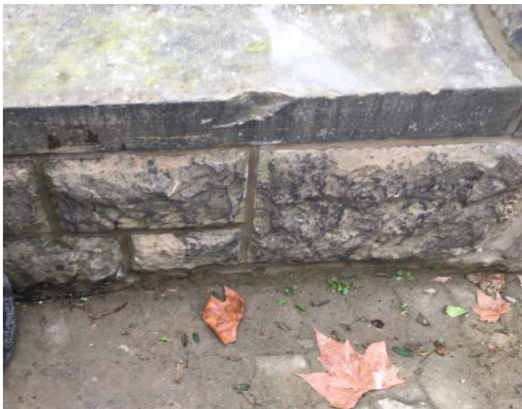
Nach Entfernung des biogenen Befalls unter sanftem Wasserstrahl...
