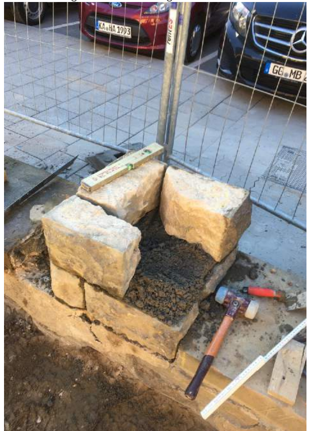
Rekonstruktion des Sandsteinpfostens ....
