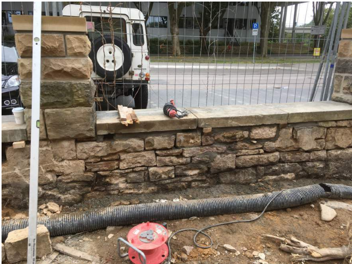
Freigeräumte und gereinigte Fugen der hinteren Mauerwerkschle
