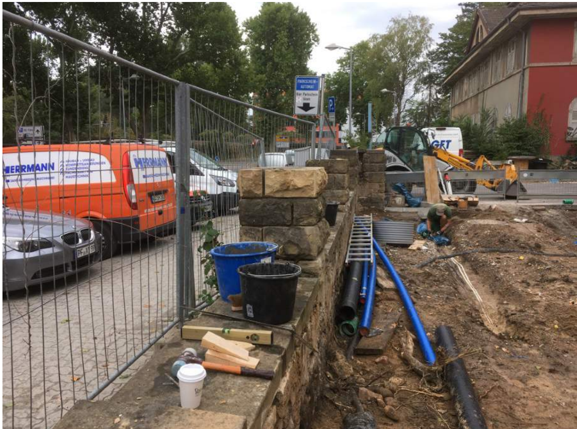
Sandsteinposten (SP 2) mit Sandsteinquader ergänzt (noch ohne Abdeckung)
