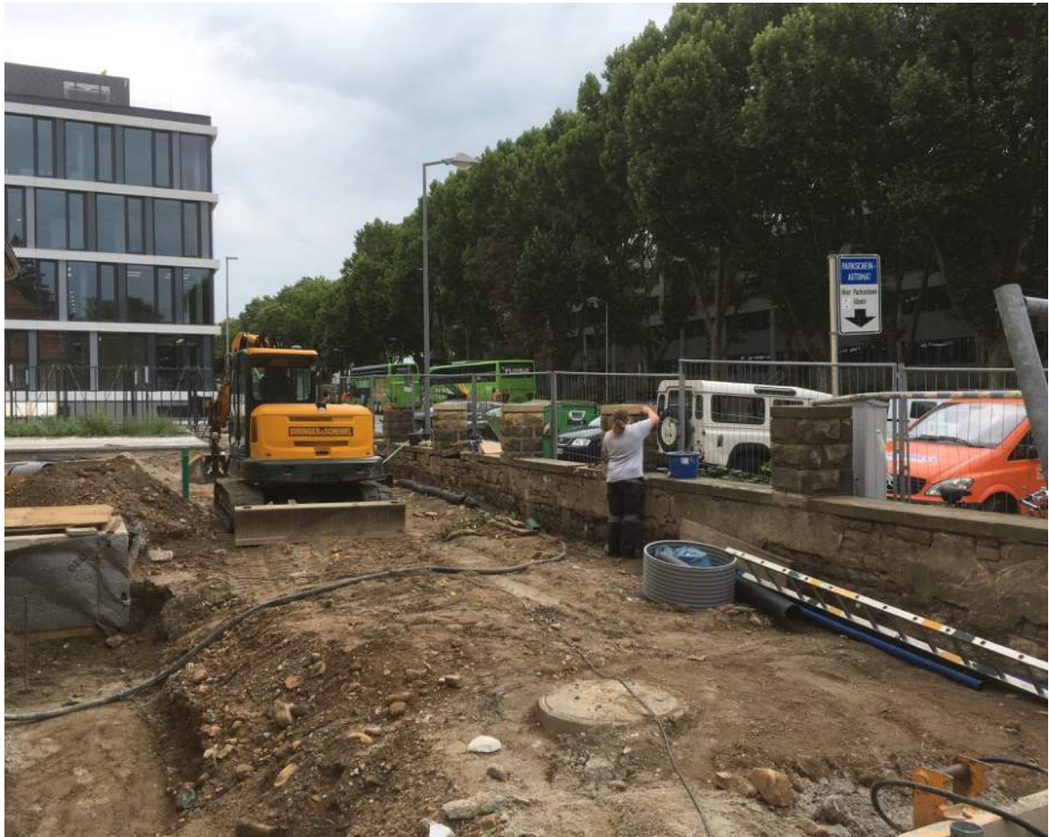
Werksteinerergänzungen an den Sandsteinpfosten mit behauenen Sandsteinen
