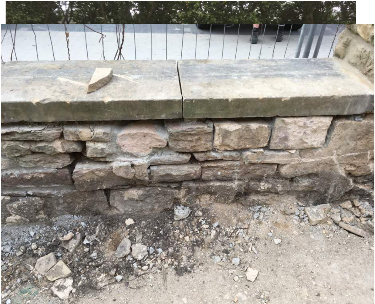
Stabilisierung des Mauerwerksverbandes mit Trasskalkmörtel
