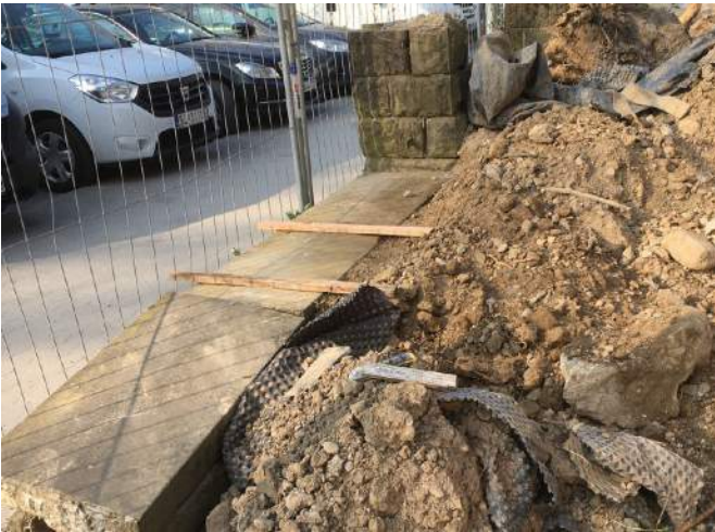
Nordansicht mit Erdaushub
