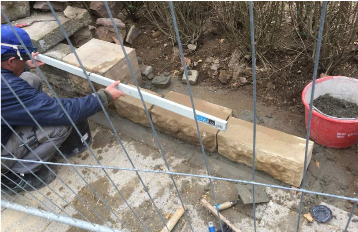
Wiederaufbau des östlichen Mauerwerksabschlusses
