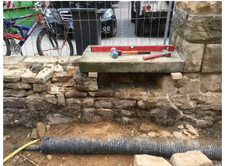
Setzen und Ausrichten der Abdeckungen
