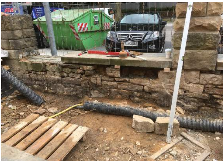
... sowie Ergänzung der rückwärtigen Mauerwerksschale ...
