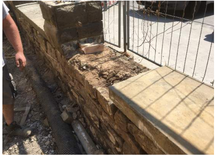
... vor und nach Abnahme der Mauerwerksabdeckungen
