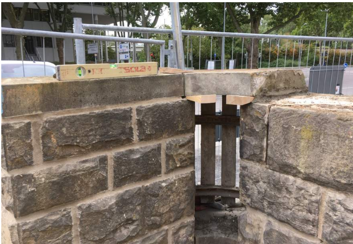
Einbau der geschweiften Abdeckung
