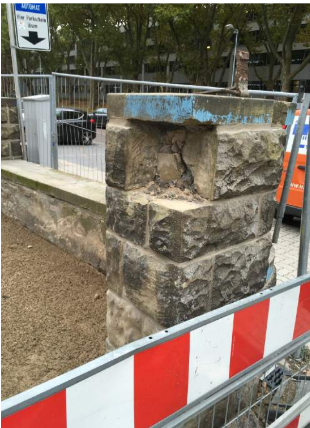
Ausbau der geschweiften Abdeckplatte TP West
