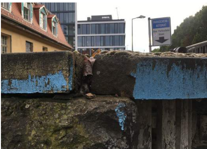
Fehlstelle an Abdeckung des westlichen Torpfeilers
