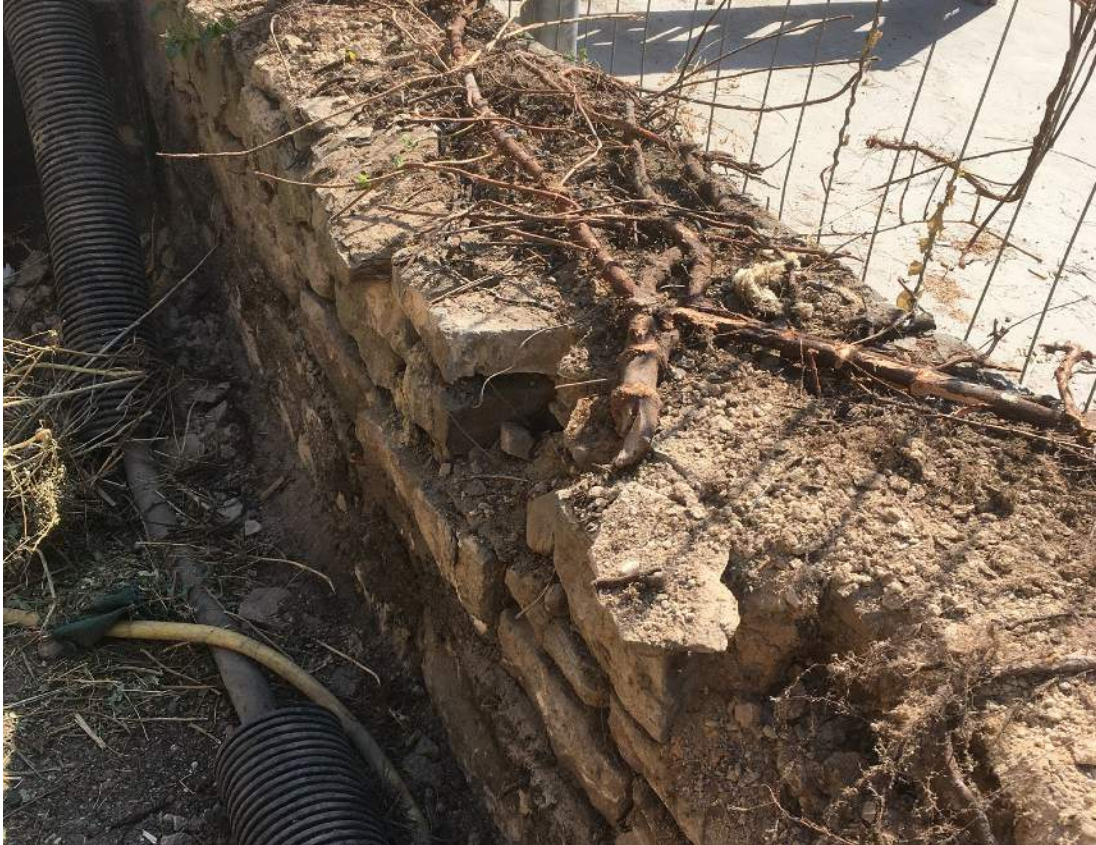
Nach Entfernen der Abdeckungen und vor dem Entfernen des Wurzelbefalls
