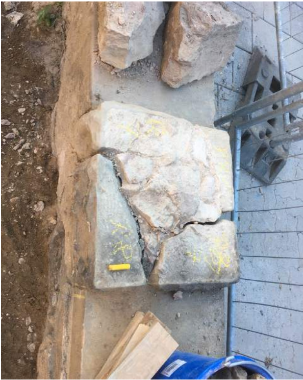
Markierung der Steine für späteren Wiederaufbau
