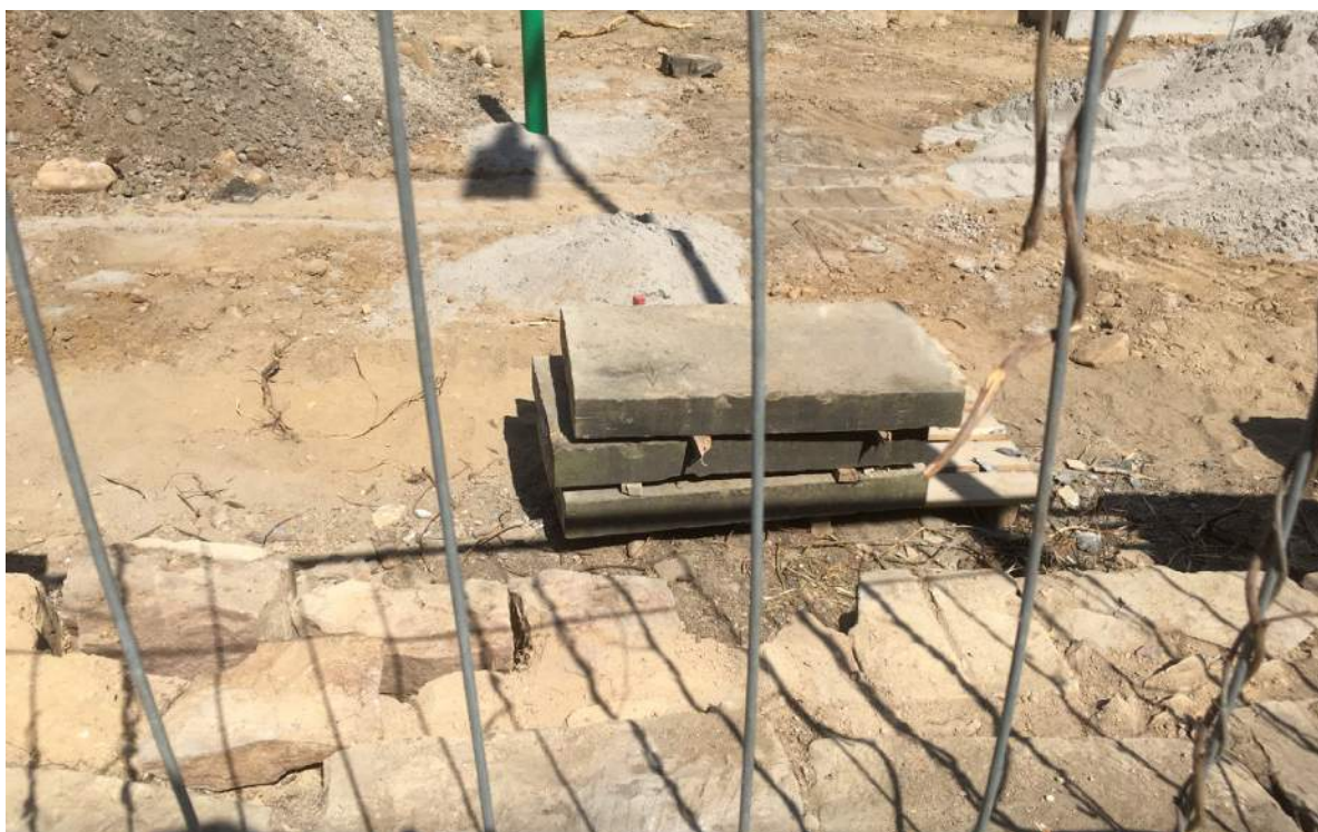
Seitlich lagernde Sandsteinabdeckungen vor dem Wiedereinbau
