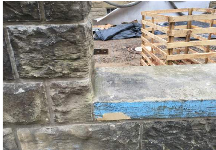
Reprofilierung an Sandsteinmauerwerksabdeckung
