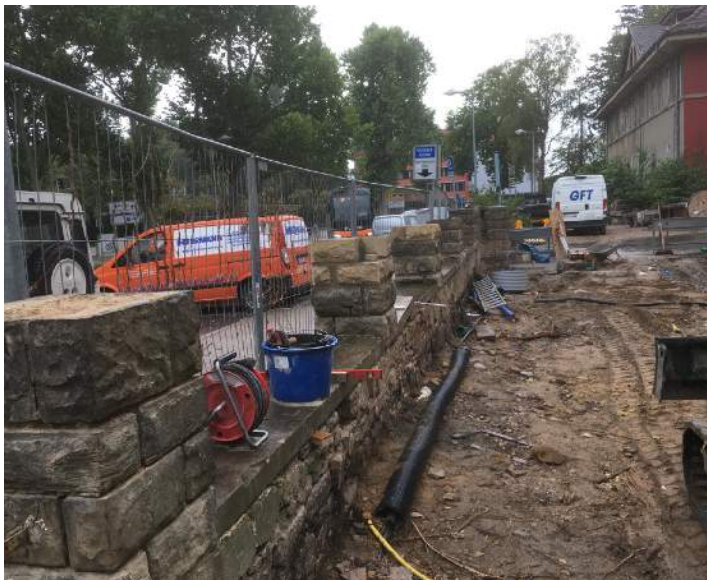
Ergänzte Sandsteinpfosten noch ohne Abdeckungen
