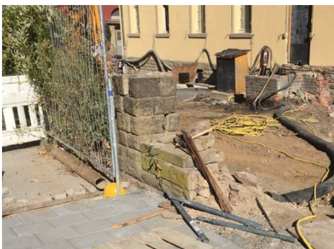
Starker biogenen Befall entlang der Südansicht
