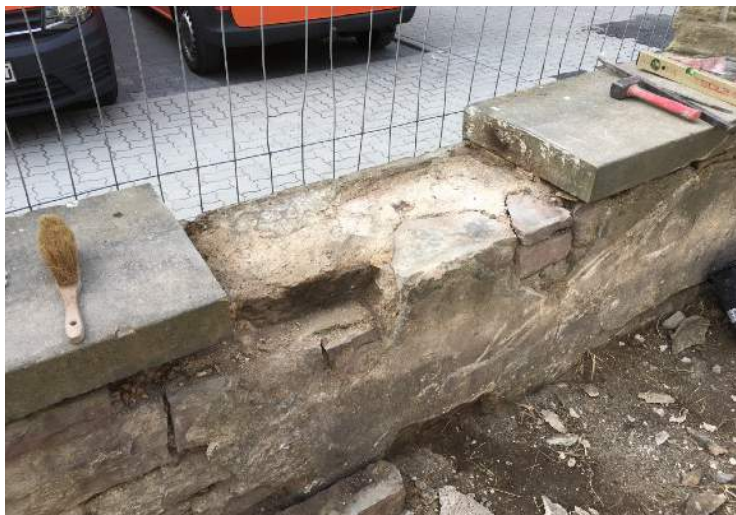
Gereinigte Auflagerfläche vor dem Einsetzen der Abdeckungen
