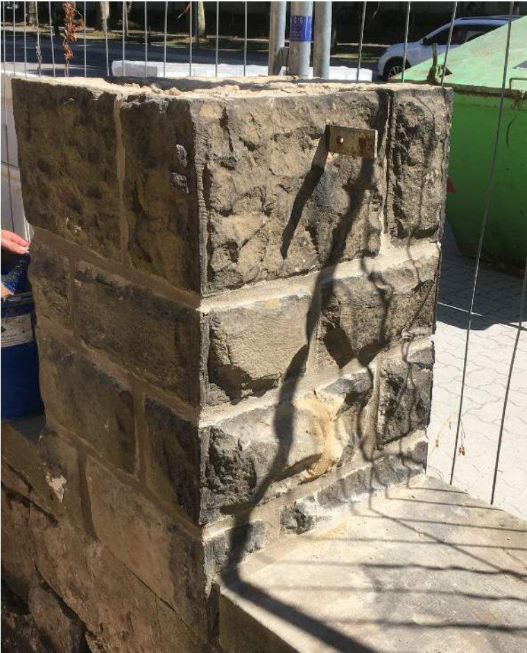
Risseverpressung im KSE Modulsystem...
