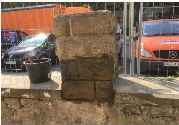
KSE Vorfestigung mit reduzierter Gelabscheidungsrate
