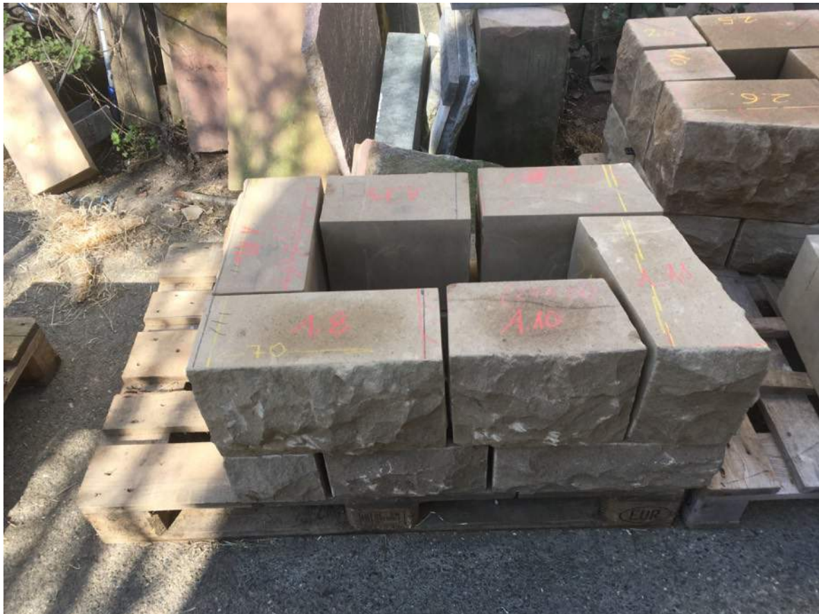
Richten der zu ersetzenden Sandsteine für den Wiedereinbau
