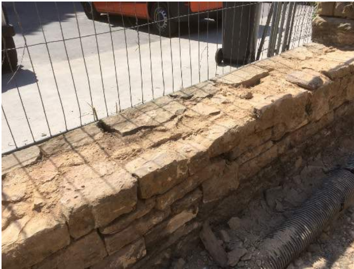
Nach Entfernen des Wurzelbefalls und Reinigen der Auflagerfläche
