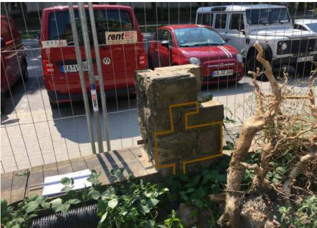
SF15: Sandsteinpfeiler 6 (SP6) Rückseite
