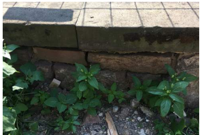
P2: Bereich zwischen TPOst und SP6
