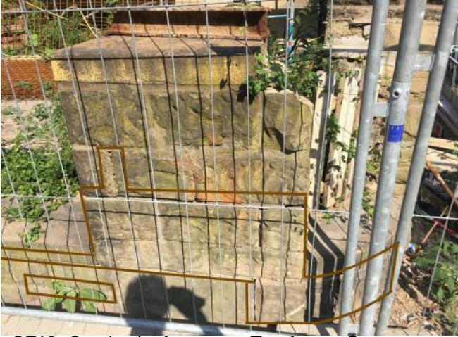
SF13: Sandsteinpfeiler vor Torpfosten Ost
