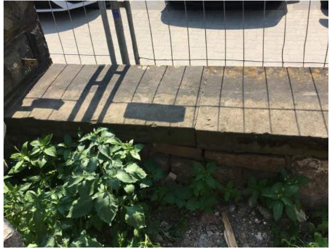
P6: Bereich zwischen SP1 und TPWest
