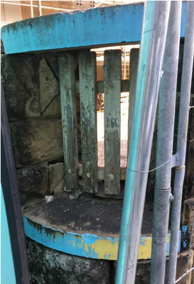
G 1: Die Stirnseiten der geschweiften Abdeckplatten G2: wie auch die daran anschliessende Mauerkrone des Torpfosten West sind deckend mit blauer Farbe bestrichen
