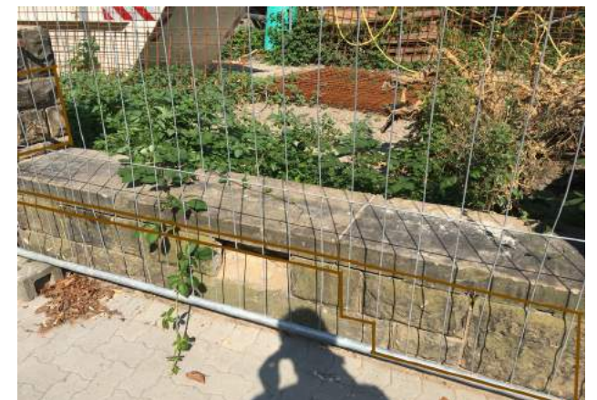
SF12: Zwischen SP6 und TPOst
