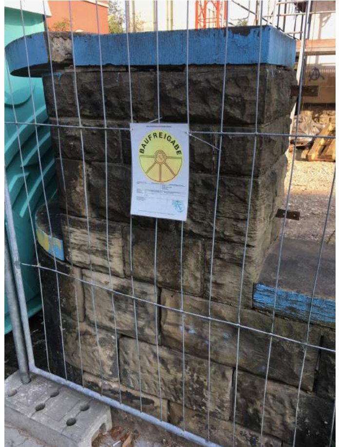
G 1: Die Stirnseiten der geschweiften Abdeckplatten G2: wie auch die daran anschliessende Mauerkrone des Torpfosten West sind deckend mit blauer Farbe bestrichen
