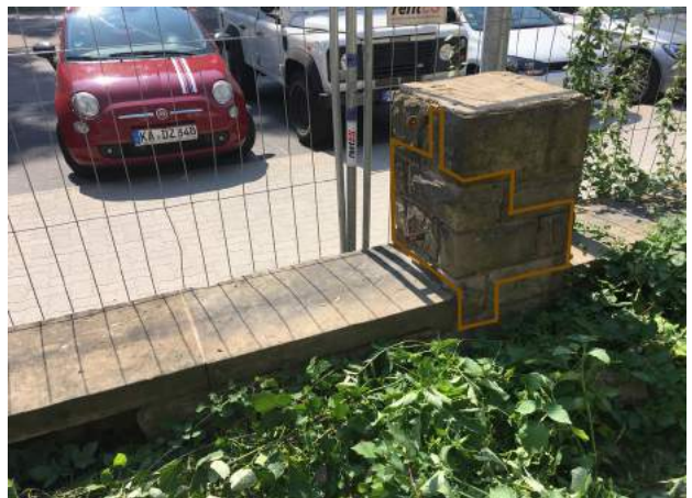
SF16: Sandsteinpfeiler (SP5) Rückseite
