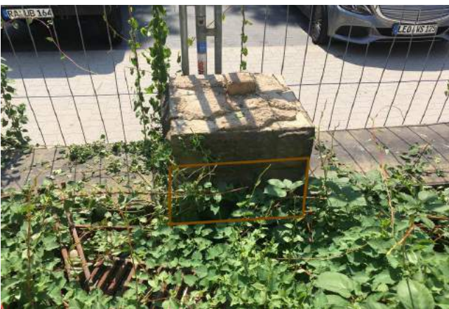
SF17: Sandsteinpfeiler (SP4) Rückansicht
