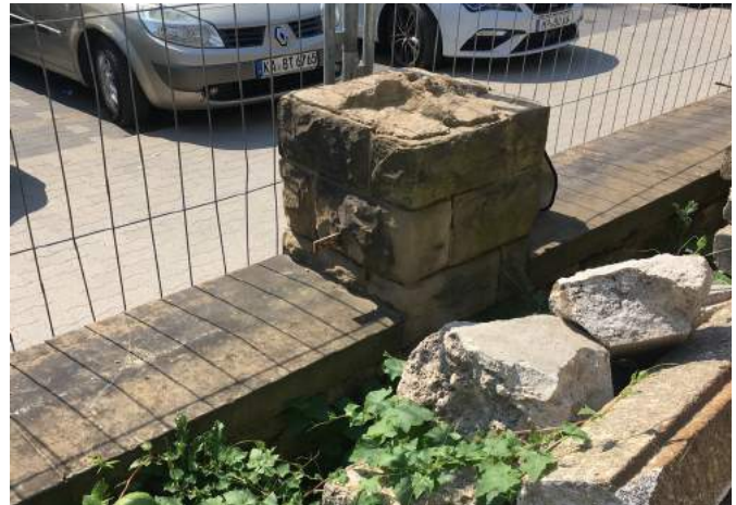
F 2: Abgetragene Mauerwerksschicht und Mauerwerkskrone (Abdeckung)
