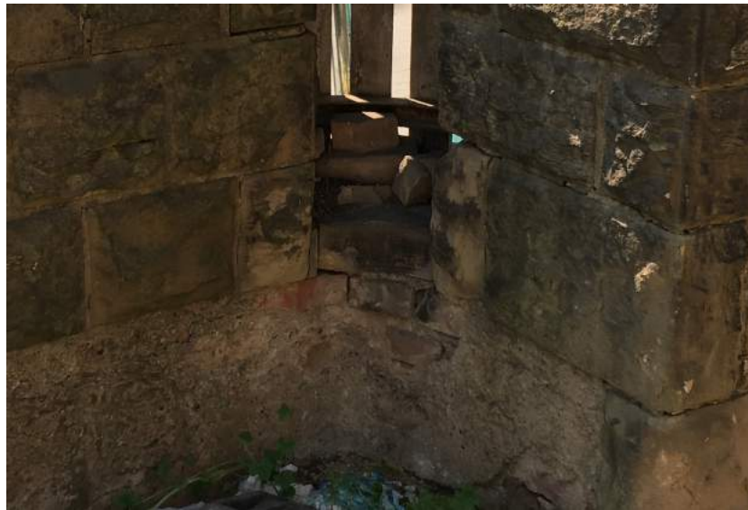
P7: Hintermauerung teilweise mit Ziegelsteinen (RF) sichtbar
