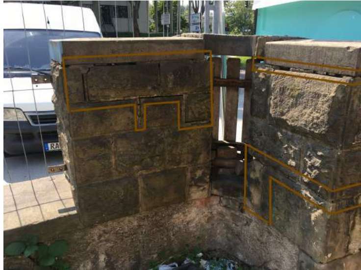
SF21: Rückansicht der Sandsteinpfosten Toreinfahrt West
