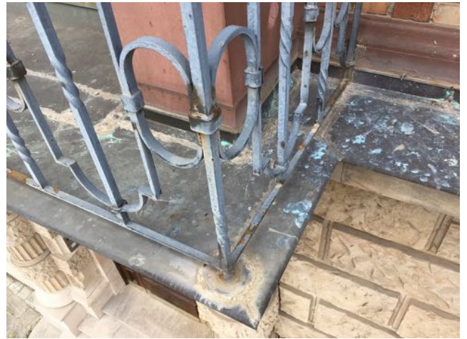
Balkongeländer 1. OG – Korrodierende Bereiche
