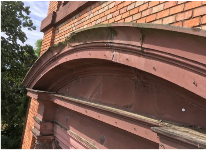
Beschriebene Haken am Segmentgiebel Mittelrisalit
