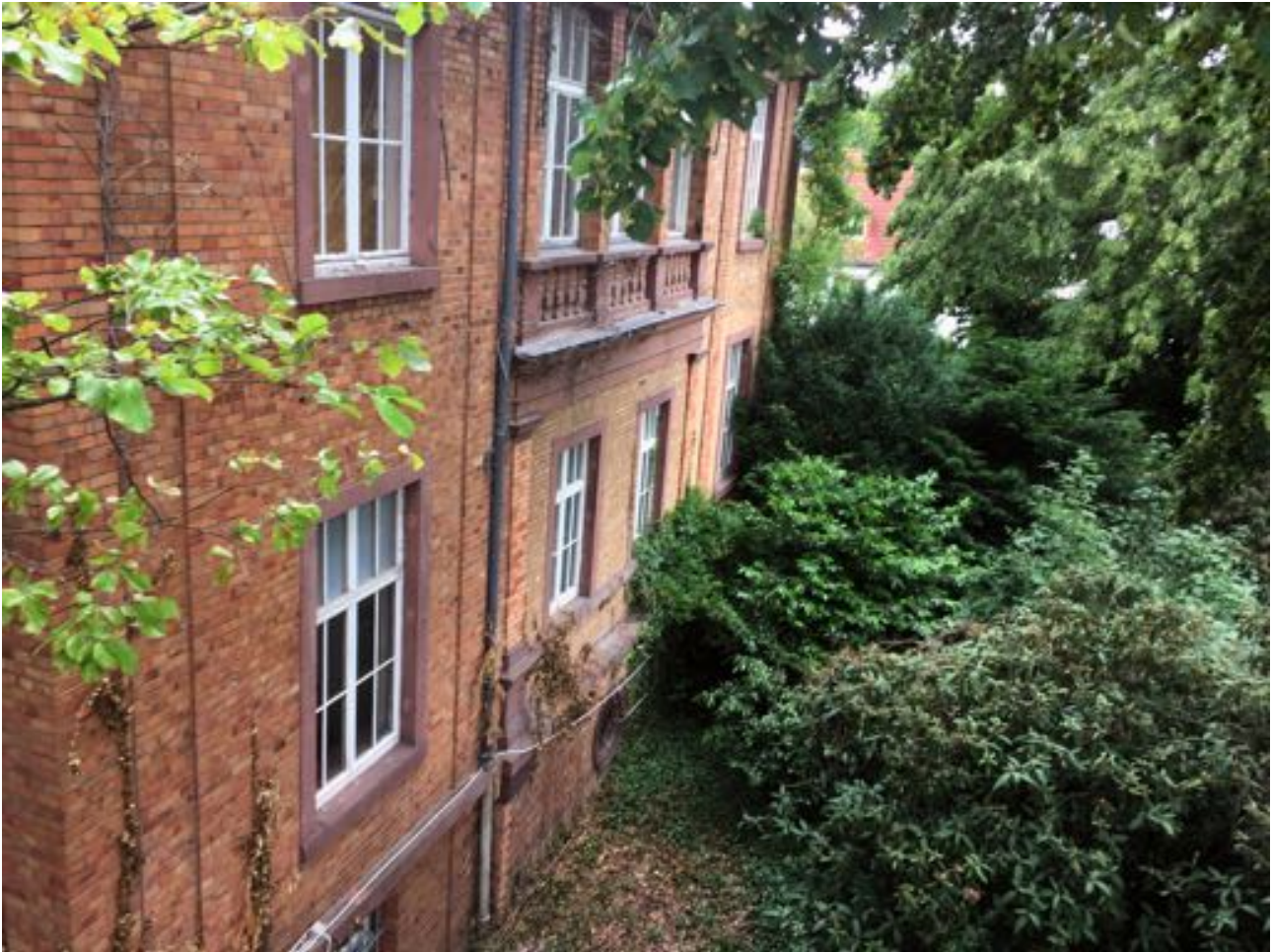
SO Fassade - Ansicht aus südlicher Richtung – EG und OG 1 des Vorbaus
