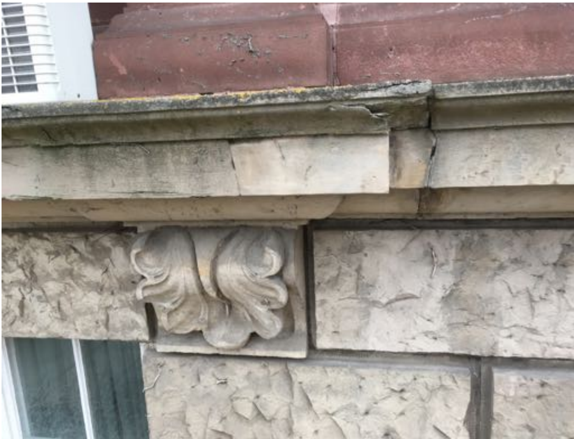
Abschlußgesims Sockelgeschoß - Ergänzung durch Vierung
