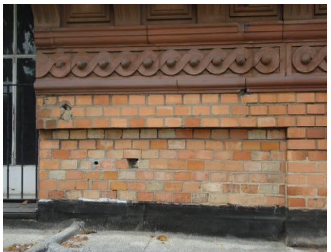
1.3.1 Dachgeschoß- Gebäudehauptkörper (Arriere corps mittig) Fehlstellen im Verband der Backsteinverblendung und der Fugen
