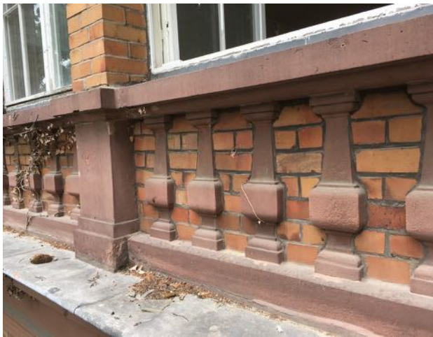
1.2.5 Ballustrade - 3 Balluster rechte Hälfte - Abschuppungen
