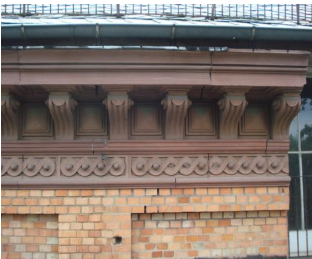
1.3.1 Dachgeschoß- Gebäudehauptkörper (Arriere corps mittig) Fehlstellen im Verband der Backsteinverblendung und der Fugen
