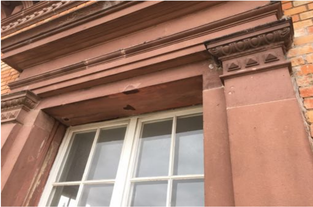
Fenstersturz 2.OG Mitte – Mörtelergänzung an der Aussenkante
