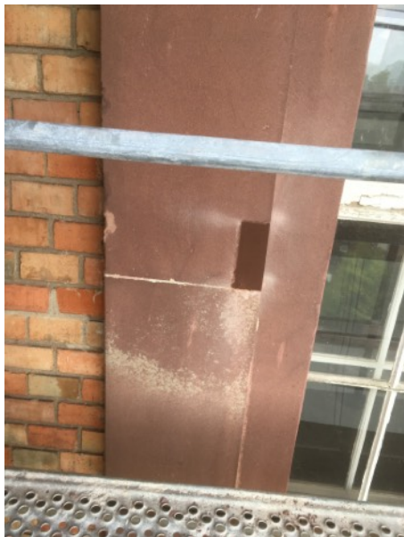
Fenstergewände 1.OG links als geometrische Antrugung und organische Antrugung mittleres
