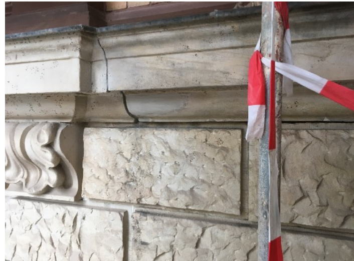
Reprofilierung des Mäanders am Kapitell der rechten Säule des Haupteingangs und Sockelprofil
