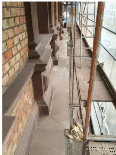
Manueller Farbabtrag an Innenleibungen der Fenstergewände im 3. OG der NO-Fassade Daneben: Vorab Trockenreinigung im 1.OG der Nordwestfassade
