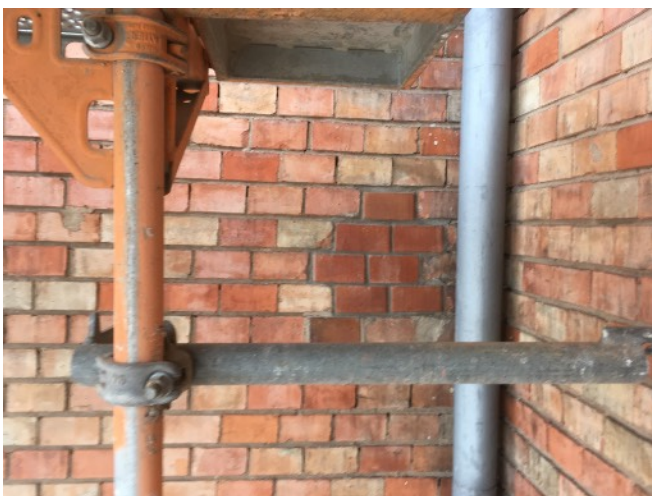
Größerflächige Ergänzung von Fehlstellen an der rechten Gebäudehälfte am Risalit 2.OG
