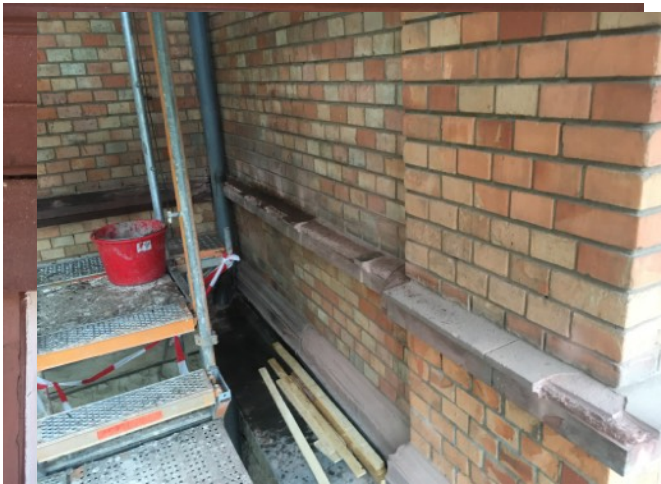
Reprofilierungen an Gurtgesimsen des 1.OG der linken Gebäudehälfte entlang des Risalit
