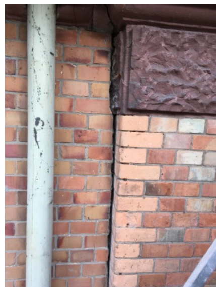
Schliessen offener Fugen ohne Flankenhaftung EG der SO-Fassade
