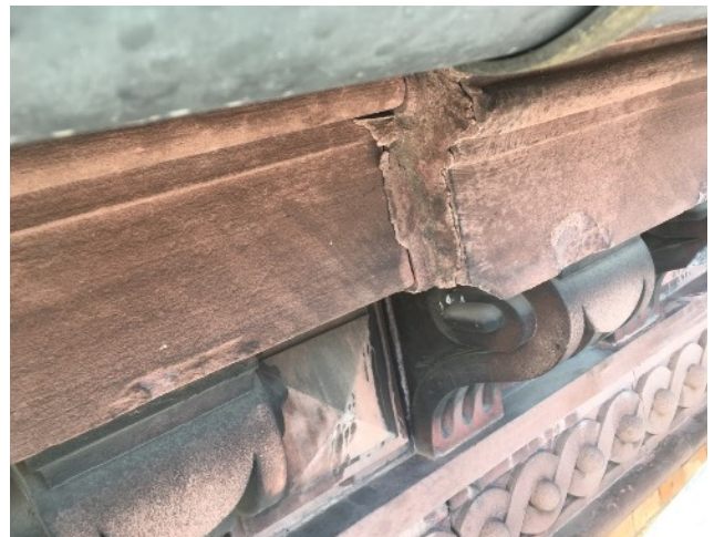
Verschiebung um 3-4 cm an der NW-Seite des Traufgesimses. links
