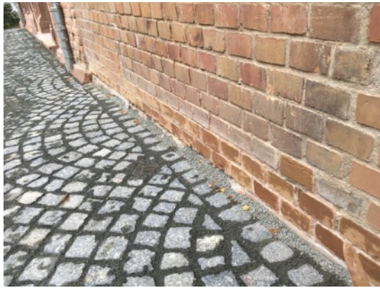
Ergänzen des Ziegelmauerwerks entlang des Sockels der SW-Seite des Nebenflügels (NW)
