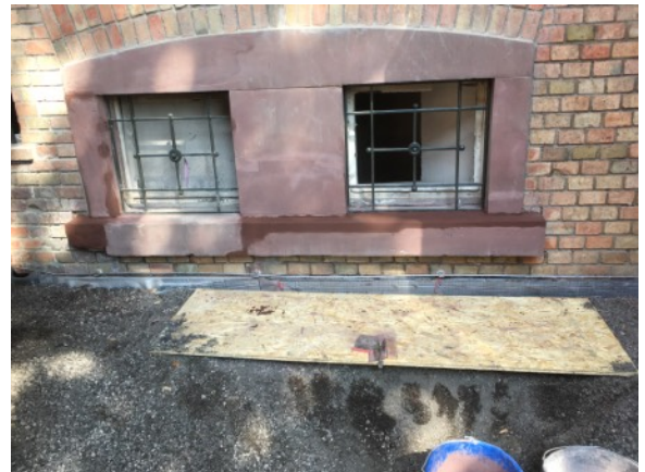
Doppelfenster Sockelgeschoß unterhalb des Treppenhauses während und nach den Rrprofilierungsarbeiten
