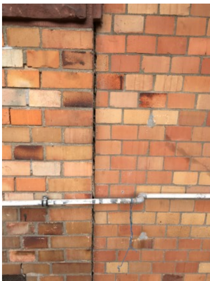
Schliessen offener Fugen ohne Flankenhaftung EG der SO-Fassade
