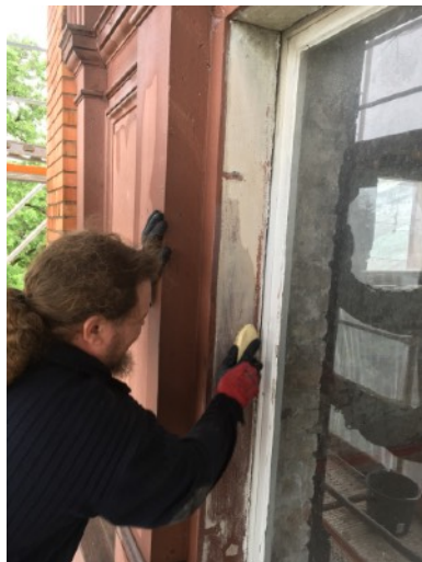
Manueller Farbabtrag an Innenleibungen der Fenstergewände im 3. OG der NO-Fassade Daneben: Vorab Trockenreinigung im 1.OG der Nordwestfassade
