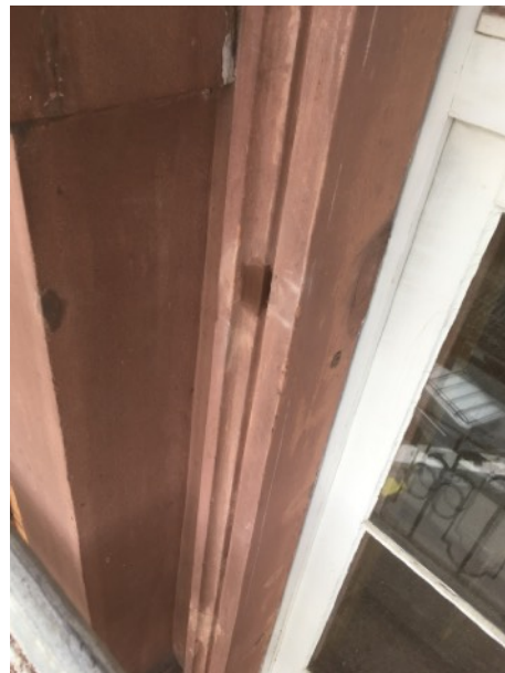
Fenstergewände 1.OG links als geometrische Antrugung und organische Antrugung mittleres
