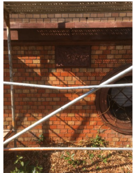
Südostfassde - Reinigungsarbeiten vorwiegend manuell unter sanftem Wasserstrahl
