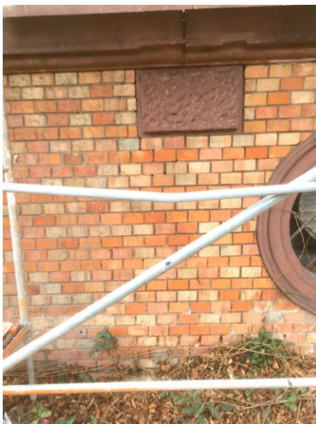
Südostfassde - Reinigungsarbeiten vorwiegend manuell unter sanftem Wasserstrahl
