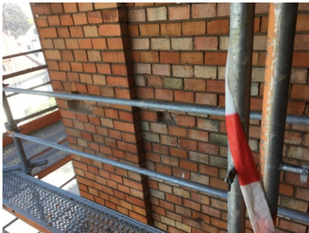
und entlang der Eckkline sowohl mit Restaurier- als auch Ersetzen durch neue Ziegel
