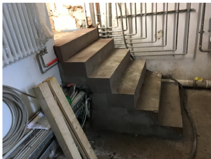
Notwendige Anpassungen an technische Erfordernisse und Fertigstellung
