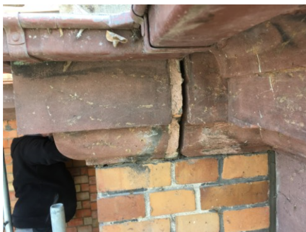
Besonders breite Fugen ohne Füllung vorab mit größerem Trasskalkmörtel vorgrundiert
