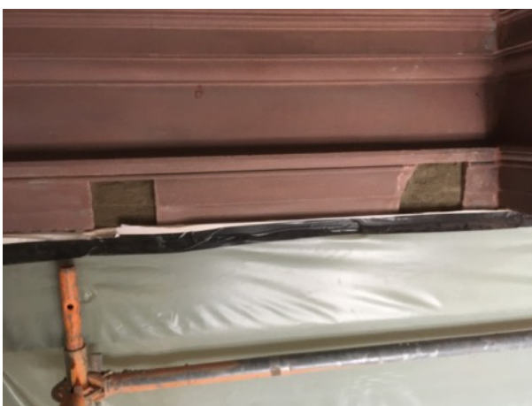
Vorbereitung für die Ergänzung grösserer Fehlstellen mit Grundiermörtel anschliessend Restauriermörtelantrag
