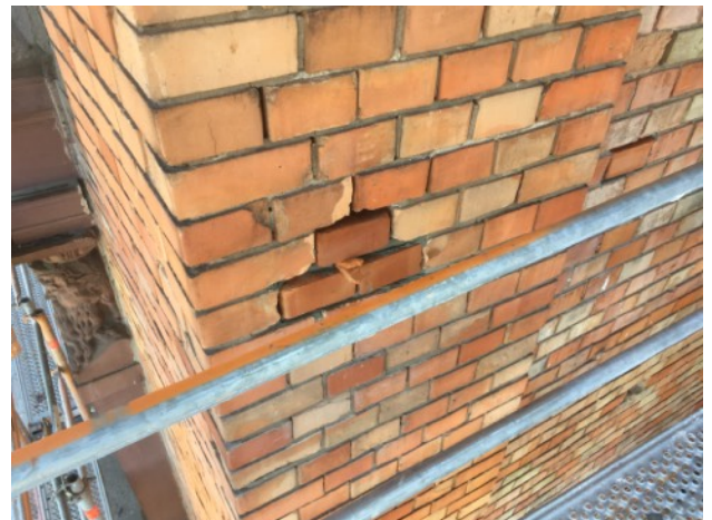
Zahlreiche Ziegelergänzungen an der NW-Seite des Turms (Turmgeschoß)
