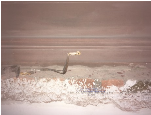
Entfernen von korrodierenden Metallteilen
