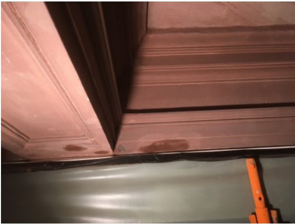
Farbgenaue Antragungen mit Restauriermörtel nach dem Abbinden
