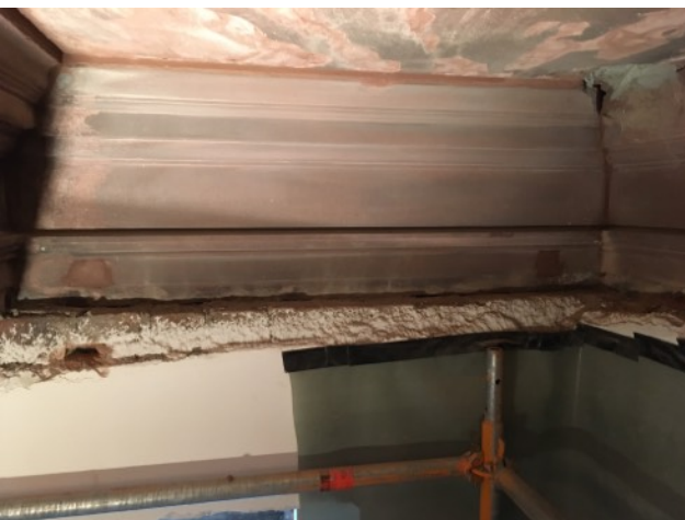
Vorbereiten des Feinmörtelantrags (marmoriert)
