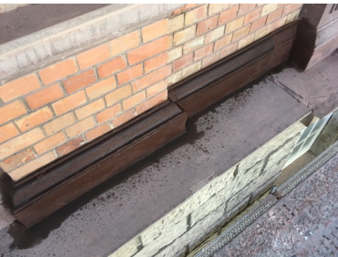
Festigen der Sockelgesimse des 1.OG der NW-Fassade
