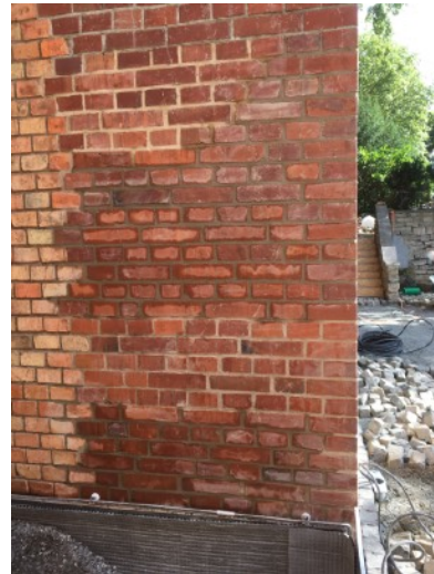
Wiederverfugung der fehlenden Verfugung EG- Bereich des Anbaus für den Aufzug
