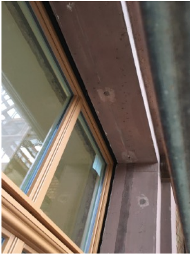
NO-Fassade, 2.OG Fenstersturz und Leitung vor Anwendung der Lasurtechnik
