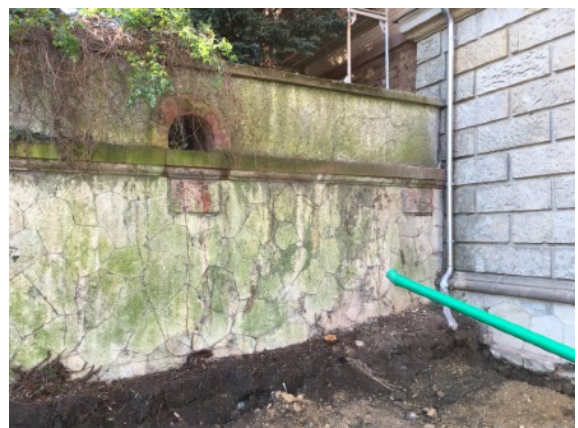
Einfriedungs- bzw. Stützmauer aus Jurakalkstein zum Park an der Nordost-Seite des Grundstücks mit starkem biogenen Befall und Verkrustungen
