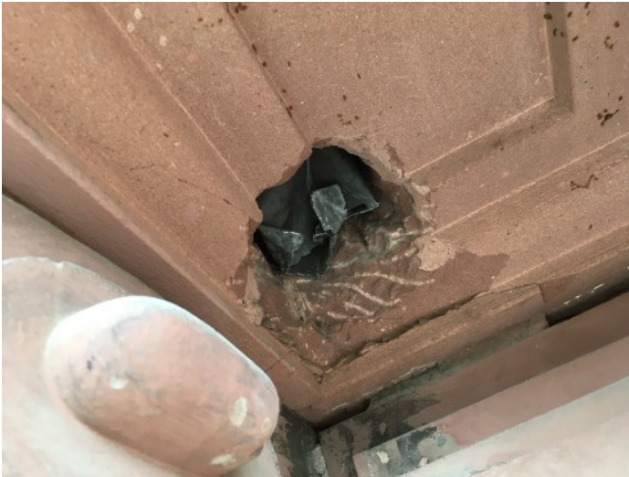
Schliessen einer ehem. Rohrdurchführung im Traufgesims im linken Randbereich der NO-Fassade
