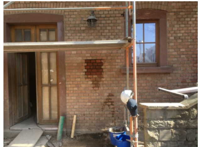
Schonendes Entfernen einer Keramikachel am Eingang des Mittelbereiches der Südwestfassade und Einbau passender Mauersteine im Reichsformat
