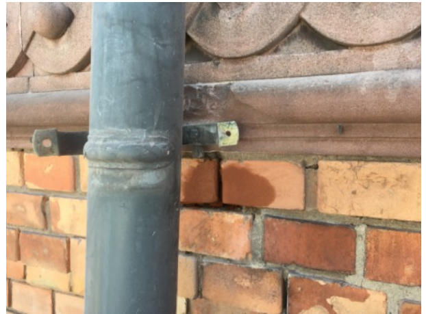
Ergänzung schadhafter Ziegelsteine durch ziegelfarbene Restauriermörtelantragungen
