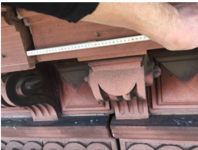
Verschiebung um 3-4 cm an der NW-Seite des Traufgesimses. rechts
