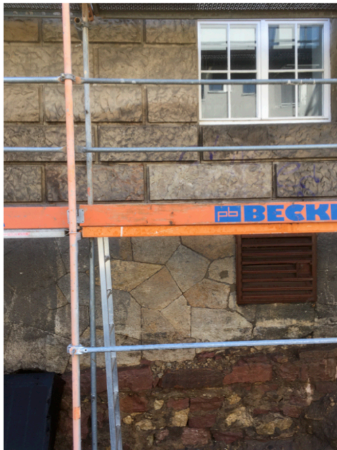
Musterfläche Reinigungsstufe 3 – Entfernen der Verunreinigung durch Graffiti und Beschichtung
