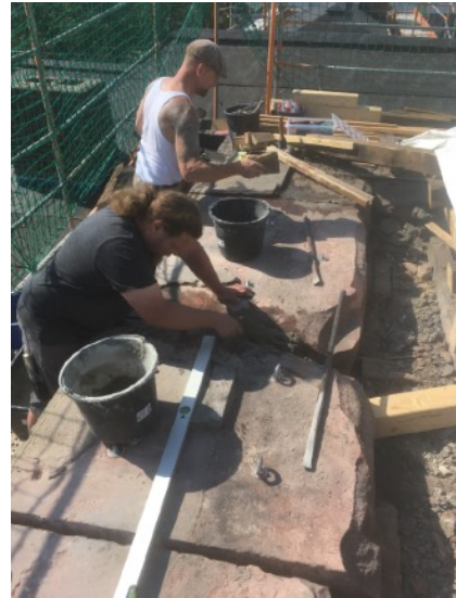
Vorsichtiges Herausheben des ersten Gesimsstückes und auf vorbereitete Kanthölzer über der Lagerfläche ablegen und an den Haken belassen zwecks zusätzlicher Absicherung.
