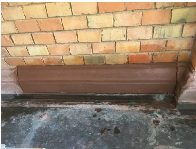
Reprofilierte Sockelprofile des 1. OG linke und rechte Gebäudehälfte
