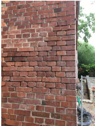
Wiederverfugung der fehlenden Verfugung EG- Bereich des Anbaus für den Aufzug
