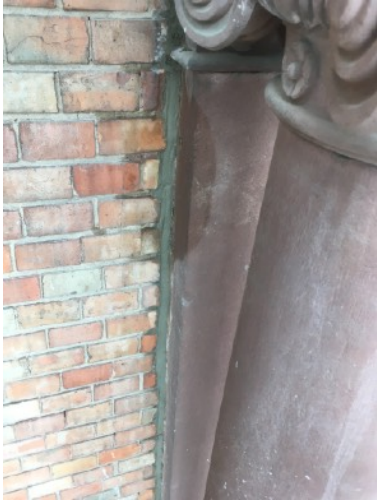
Anschlußverfugung Ziegelmauerwerk an Sandstein.... entspricht der Mauerwerksverfugung mit Trass-Kalkmörtel
