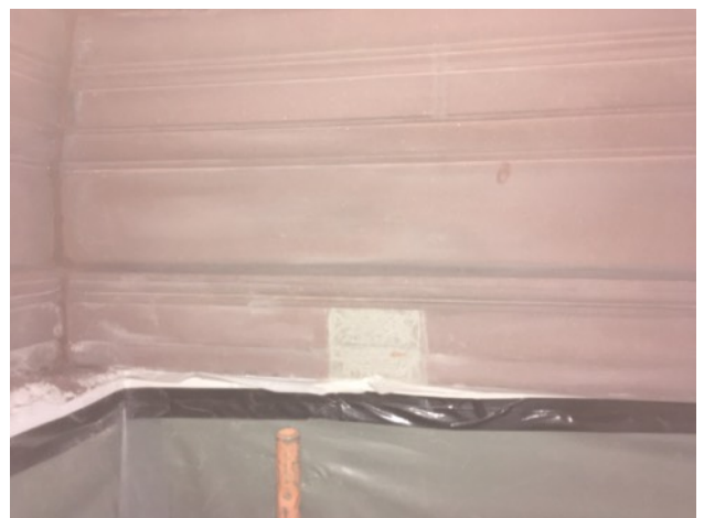
Antragungen mit Restauriermörtel und abgebundene sowie aufgeraute Grundiermörtelantragungen...
