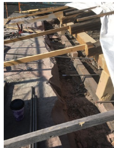
Rückseitiges Einbringen der Bohrungen, Einrichten und Einpressen der Spannstäbe in Verbundmörtel
