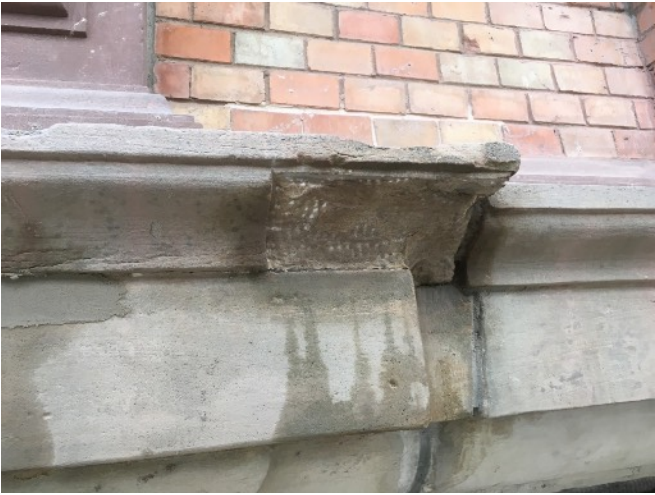
Gurtgesims des Hochparterres mit Reprofilierungen
