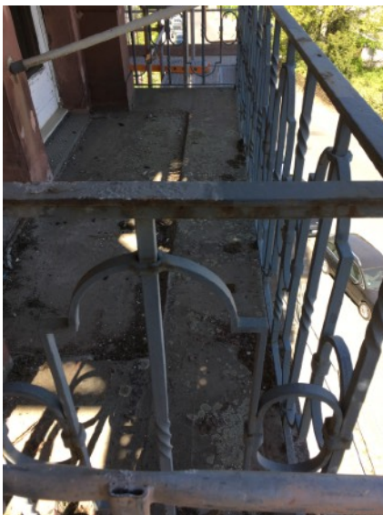
Balkonoberfläche Sandstein im 2. OG der NO-Fassade mit starkem Algen- und Flechtenbefall
