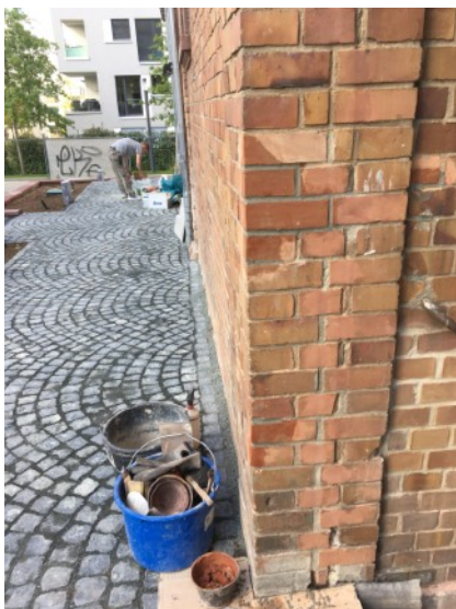
Ergänzungen an der Ecklisene des Nebenflügels und Fassade 2.OG. mit Resturiermörtel
