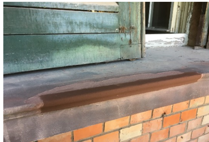
Reprofilierung der Vorderkante des Fenstergesims 1.OG
