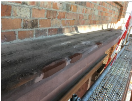
Ergänzung am Gesims des Fenstersturzes 2.OG
