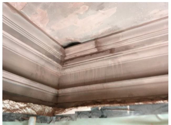
Eingepasste und profilierte Vierung
