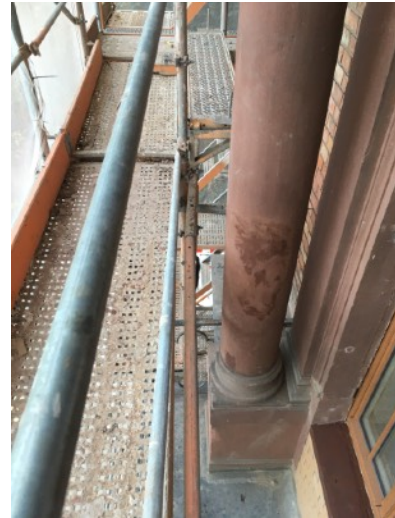
Leibungen der Fensteröffnung und Säulen des Balkons im 1. OG der NO Fassade Die Säule wurde nur partiell lasiert, um eine intakte ältere Anstrichung anzupassen
