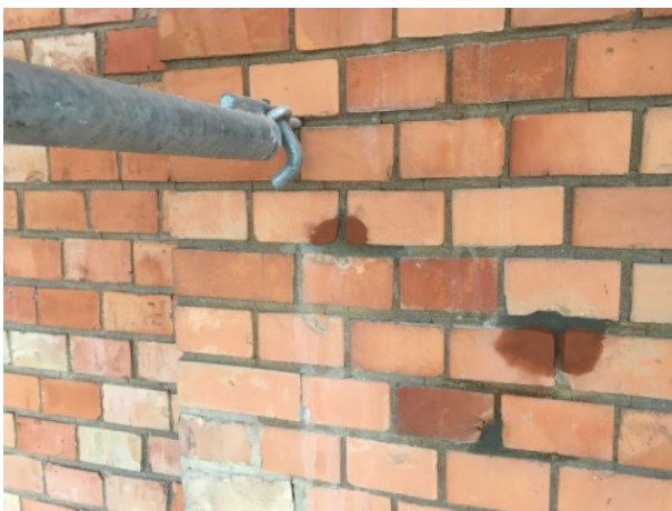
und Anpassen des Fugenbildes unter Verwendung von Fugenmörtel TK
