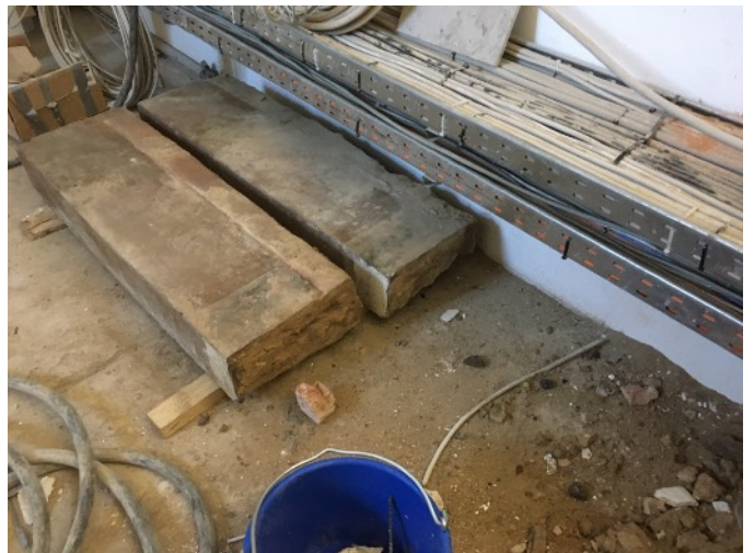
Für Ergänzung vorgesehene Blockstufen und gesicherter noch verwendbarer Bestand
