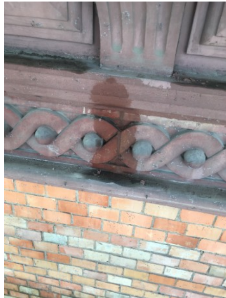
Der Fries aus Romanzementguß mit farblich angepasstem Restauriermörtel
