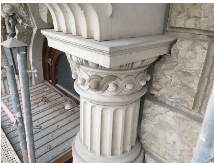
Reprofilierung des Mäanders am Kapitell der rechten Säule des Haupteingangs und Sockelprofil
