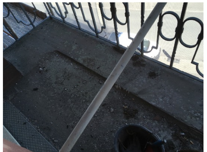
Balkonoberfläche Sandstein im 2. OG der NO-Fassade mit starkem Algen- und Flechtenbefall
