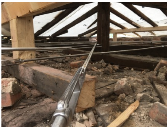
Verbinden und leichtes Anziehen der Spannschloßmuttern
