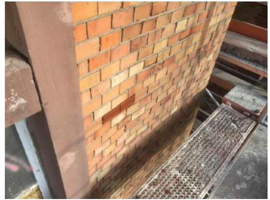
Ergänzen des Ziegelmauerwerks entlang des Sockels der SW-Seite des Nebenflügels (NW)
