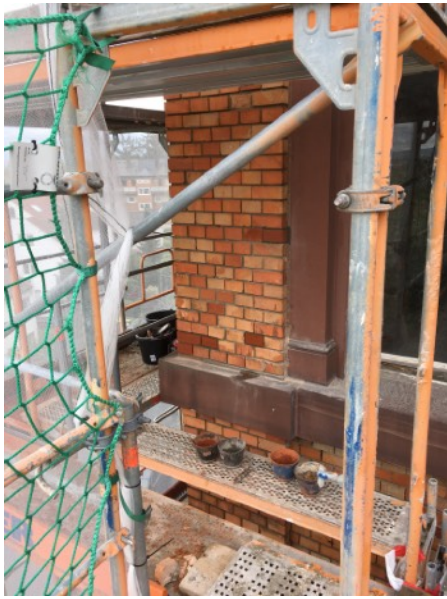
Zahlreiche Ziegelergänzungen an der NW-Seite des Turms (Turmgeschoß)
