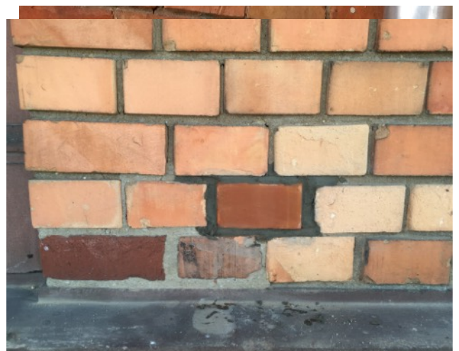
Nordwestfassade Erweiterungsbau des linken Gebäudeflügels - Ersetzen unpassender Mauersteine durch passende Ziegel im Reichsformat von 1879
