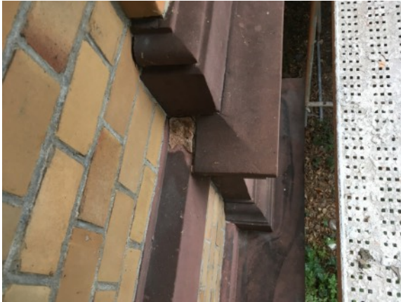
Reprofilerte Gesimsecke unterhalb des Altars
