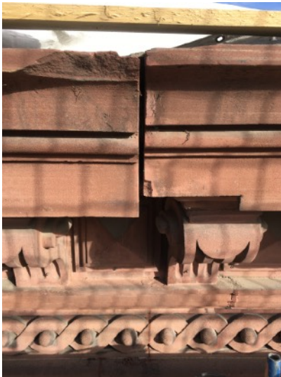
Die mittleren drei Gesimse haben sich bis zu 5 cm nach außenverschoben
