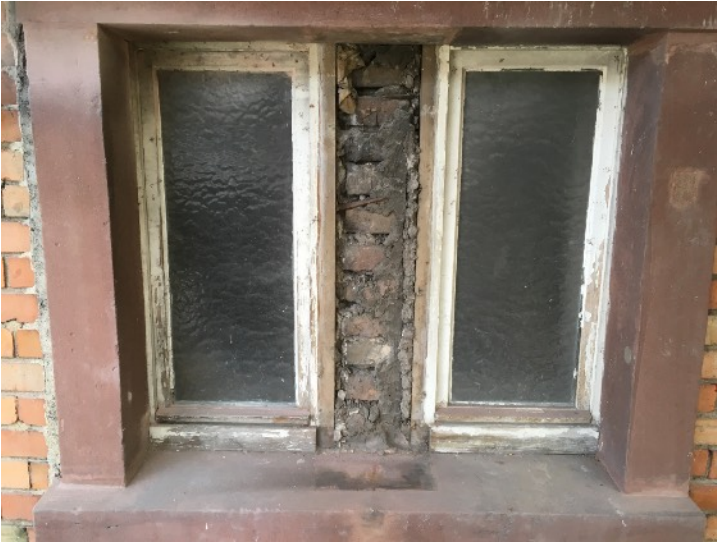
Ausbau des Mittelpostens zur Angleichung der Fensterformate im 3. OG. SW-Fassade
