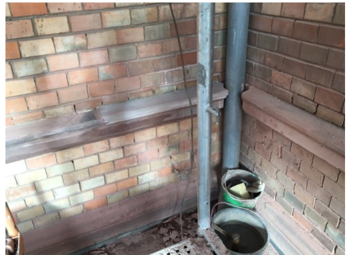
Gurtgesims 1. OG Gebäudeflügel links
