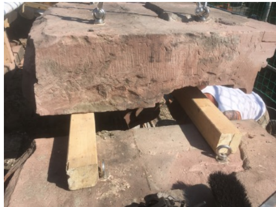
Vorsichtiges Herausheben des ersten Gesimsstückes und auf vorbereitete Kanthölzer über der Lagerfläche ablegen und an den Haken belassen zwecks zusätzlicher Absicherung.
