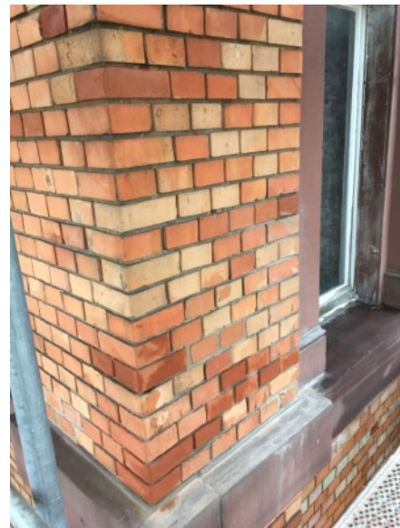
Zahlreiche Ziegelergänzungen an der NW-Seite des Turms (Turmgeschoß)
