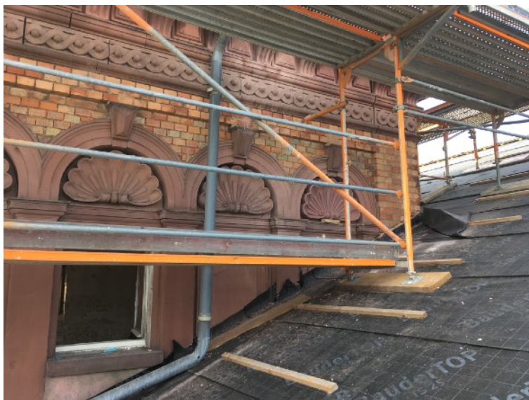
Nach Einbau an der Nord-West-Seite
