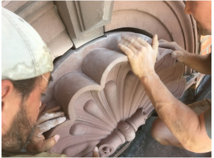
Werkstück auf dem Gerüst an der Einbaustelle kurz vor Einbau und während des Einbaus
