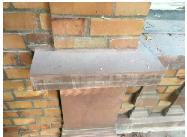
Vorbereiten der Ballustradenabdeckung für Antragung und nach der Reprofilierung
