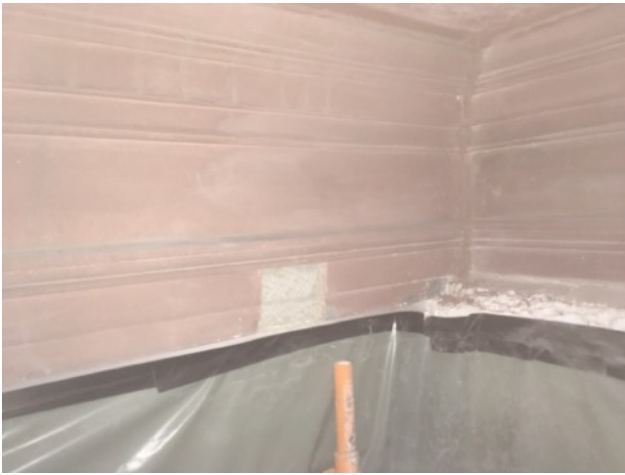
Grundiermörtelantrag in die dafür vorbereiteten Vierungen
