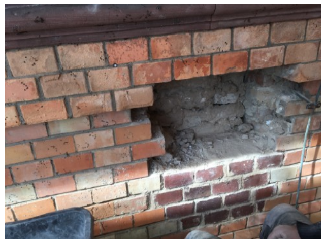
Entfernen sowohl schadhafter als auch unpassender Ziegelmauerwerksfläche und Ersetzen durch
