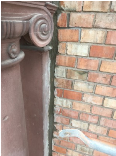
Anschlußverfugung Ziegelmauerwerk an Sandstein.... entspricht der Mauerwerksverfugung mit Trass-Kalkmörtel
