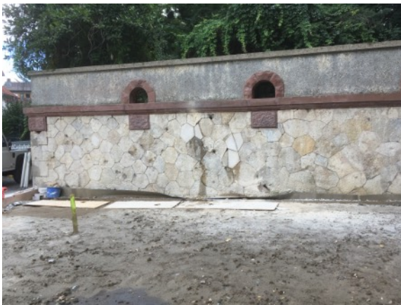
Reinigung teils manuell mit Wasserstrahl und im IOS-Verfahren mit niedrigem Druck und feinstem Strahlgut
