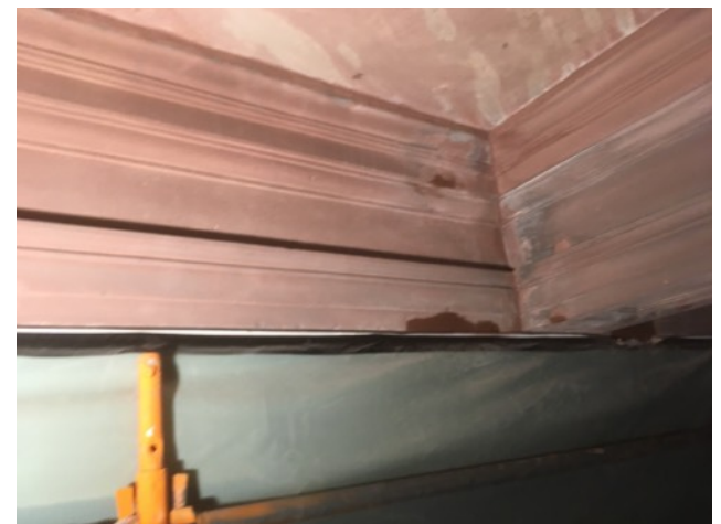
Schliessen der Anschlußfugem zwischen Gesimsen und Decke des Altans
