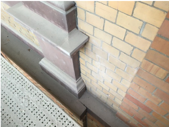
Gurtgesims unterhalb der rechten Lisene und linken Lisene des Altars 2.OG
