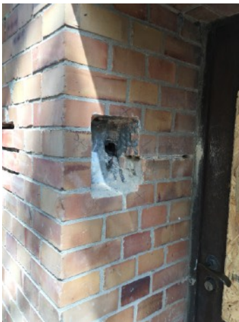
Schliessen einer grösseren Fehlstelle zum Eingang des Anbaus der SW-Fassade
