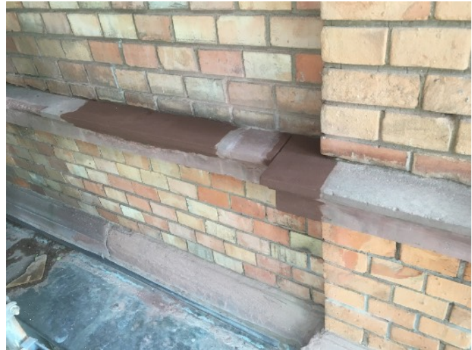
Reprofilierungen an Gurtgesimsen des 1.OG der linken Gebäudehälfte entlang des Risalit
