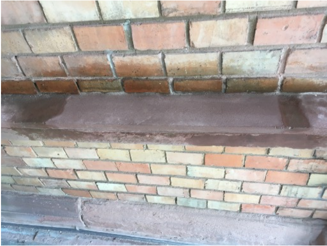
Einsatz von Anböschmörtel im KSE-Modulsystem
