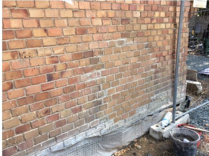
Ausbau der Eisenklappe und Schliessen der entstandenen Öffnung mit RF-Ziegelsteinen
