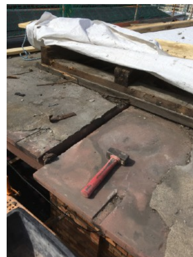
Freilegen der Fugenbereiche um das schonende Herausheben zu sichern
