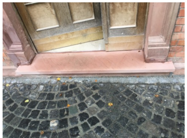
Austausch und Anpassen einer beschädigten Türschwelle sowie einer Trittstufe an den Eingangsbereichen der Süd-West-Fassade.
