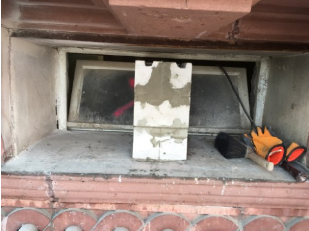
Unterkonstruktion für die zusätzliche Konsole im Bereich des anzupassenden Fensters an der Nord-Ostfassade und nach Einbau.
