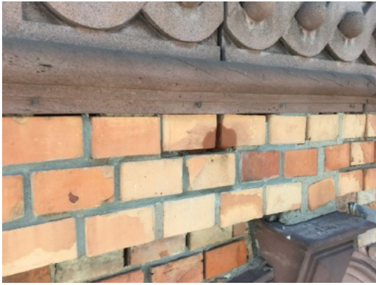
Ergänzungen im Bereich des DG unterhalb des Traufgesimses mit Restauriermörtel
