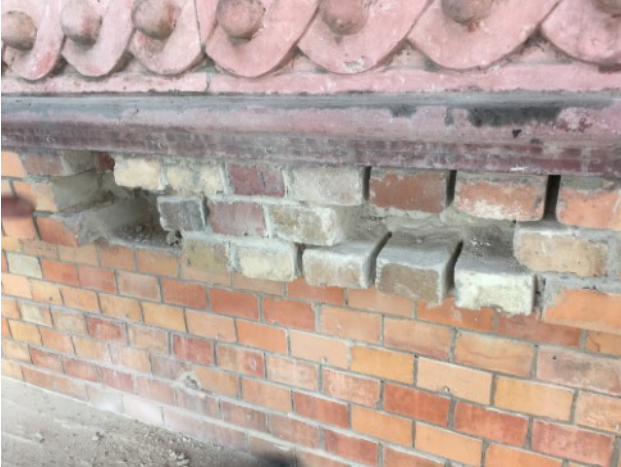
Ersetzen von flächig eingebauten fehlerhaften Ziegelsteinen durch passende unterhalb des Traufgesims (3.OG Fassadenmitte)
