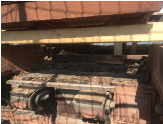
Säubern der Auflager und Überprüfen der Konsolen
