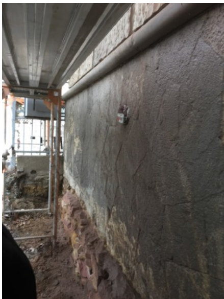
Jurakalksteinsockel noch mit grauer Beschichtung.
