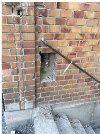
Entfernen einer Wasserentnahmestelle (Rohrleitungen) und vermauern am Treppenabgang SW-Seite
