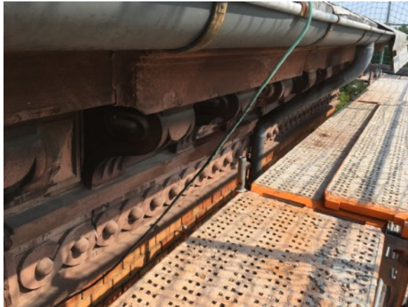
verschobene Traufgesimse vor Beginn der Sanierung
