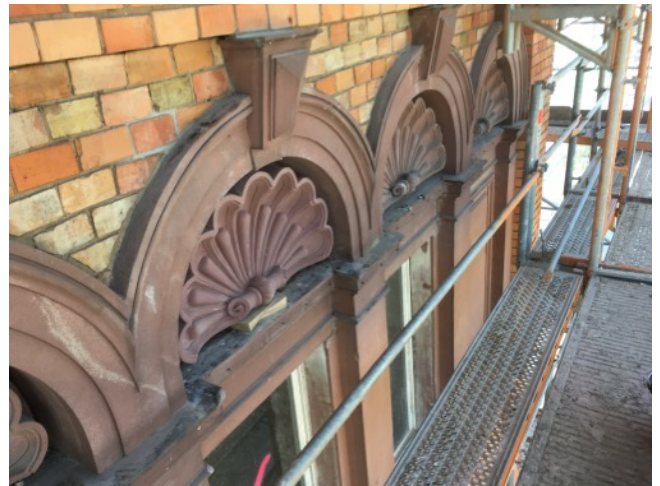
Eingepasst und im eingebauten Zustand an der Nord-Ost-Fassade
