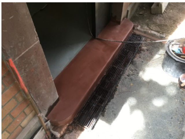
Restaurierte Türschwelle mit 2 komponentigem Restauriermörtel (Epasit)
