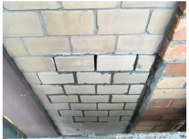
Nordwestfassade Erweiterungsbau des linken Gebäudeflügels - Ersetzen unpassender Mauersteine durch passende Ziegel im Reichsformat von 1879
