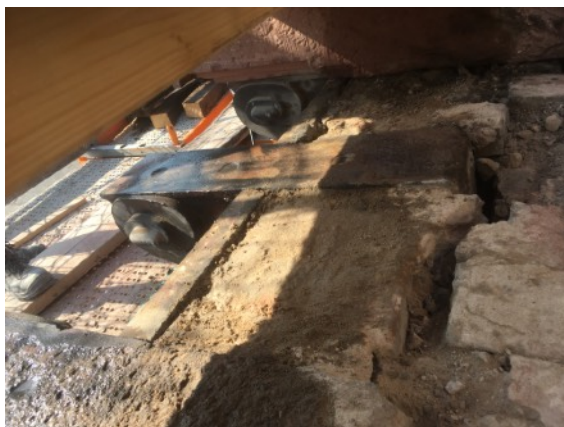
Vorbereiten zum Wiedereinsetzen in das Mörtelbett
