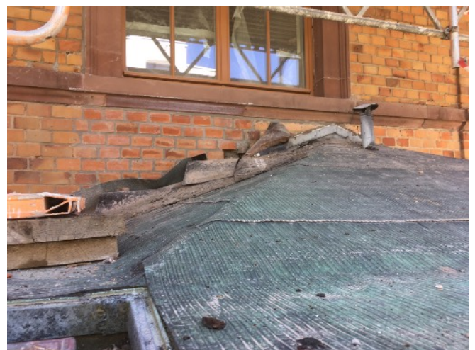
Schliessen einer großflächigen Lücke oberhalb des Anbaus des Nebengebäudes NW/SW
