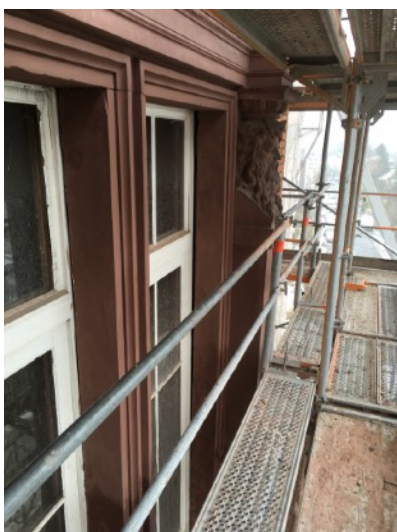
Leibung am Balkon des 2. OG der NO-Fassade
