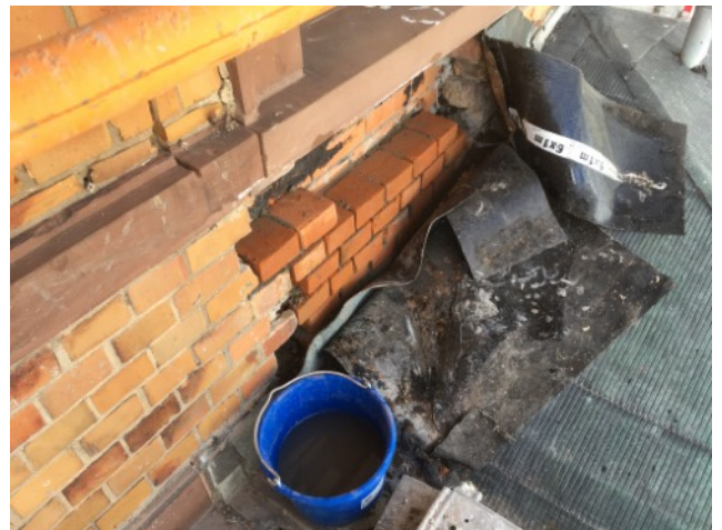
Ersetzen von flächig eingebauten fehlerhaften Ziegelsteinen durch passende unterhalb des Traufgesims (3.OG Fassadenmitte)
