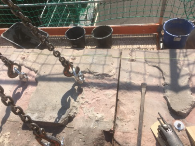
Einsetzen des letzten Gesimsstückes auf der SO- Seite des Turms und Vorbereitung für die die Fortsetzung der Versetzarbeiten an der Nordwest-Seite
