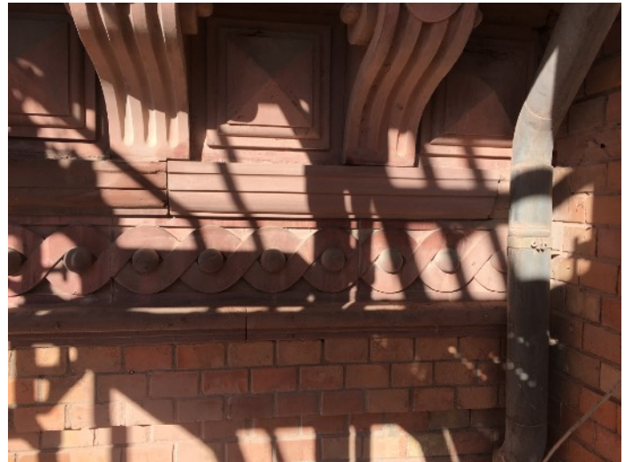
Unteres Traufgesims linke Gebäudehälfte
