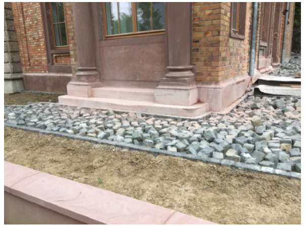
Sandsteinverfugung am Sockelbereich mit pigmentiertem Restauriermörtel
