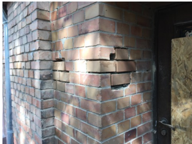
Schliessen einer grösseren Fehlstelle zum Eingang des Anbaus der SW-Fassade
