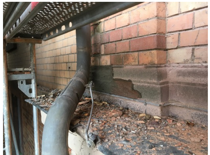
Pilasterbasis des linken Fenstergewands und Sockelprofil des 1. OG des rechten Gebäudeflügels
