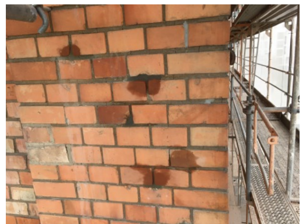
und Anpassen des Fugenbildes unter Verwendung von Fugenmörtel TK
