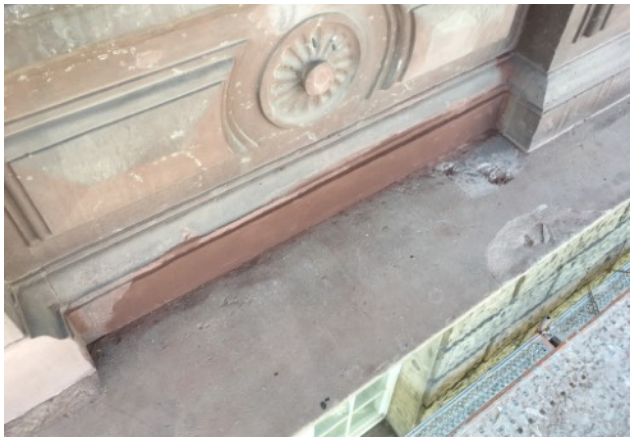
Reprofiliertes Sockelgesims 1. OG unterhalb linkes Fenster
