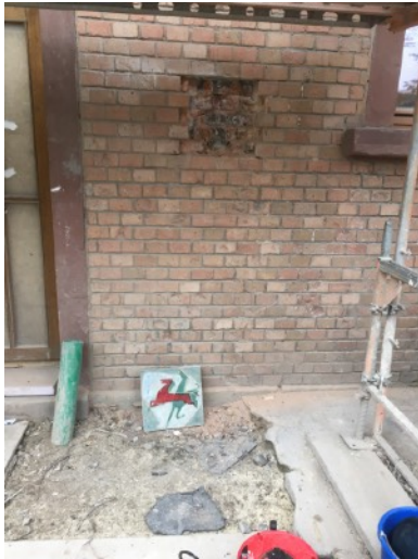
Schonendes Entfernen einer Keramikachel am Eingang des Mittelbereiches der Südwestfassade und Einbau passender Mauersteine im Reichsformat
