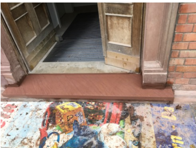
Austausch und Anpassen einer beschädigten Türschwelle sowie einer Trittstufe an den Eingangsbereichen der Süd-West-Fassade.
