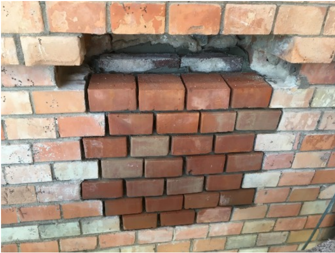
passende Mauerwerkssteine im Reichsformat Nordwestfassade 2. OG linke Gebäudehälfte
