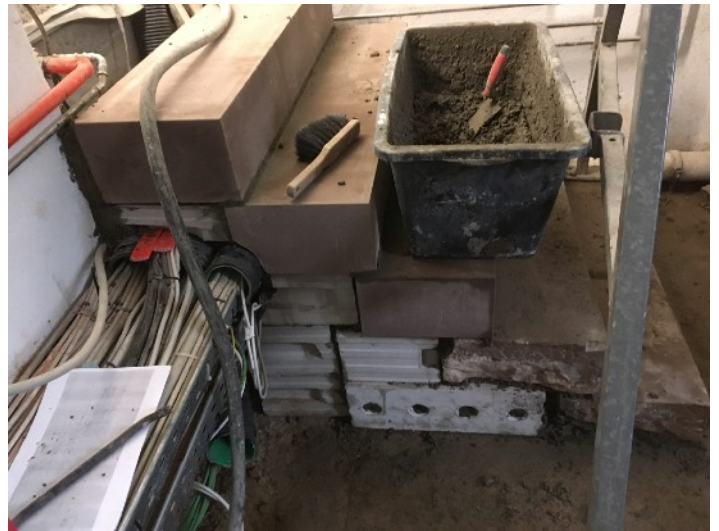
Massive Unterkonstruktion (Beton und KS-Plansteine) und Integration der Bestandsstufen
