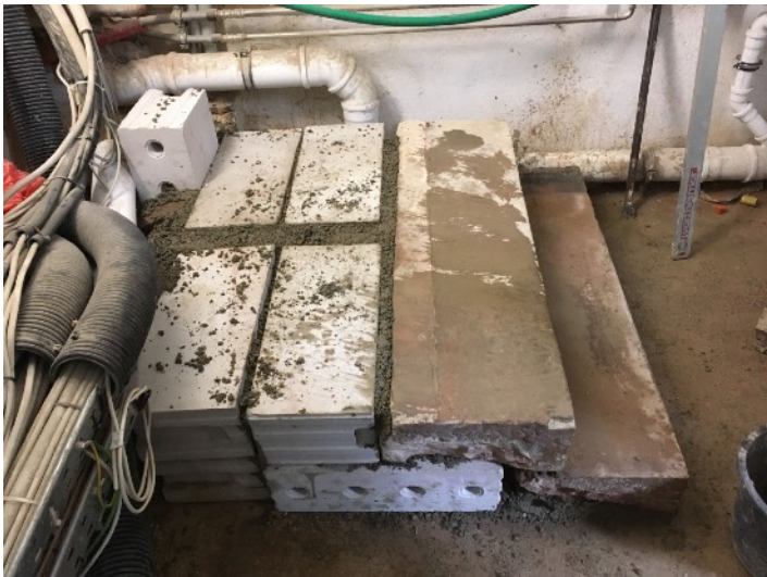
Massive Unterkonstruktion (Beton und KS-Plansteine) und Integration der Bestandsstufen
