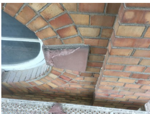
Kämpferstein am Rundfenster des 1. OG. vor und nach der Reprofilierung
