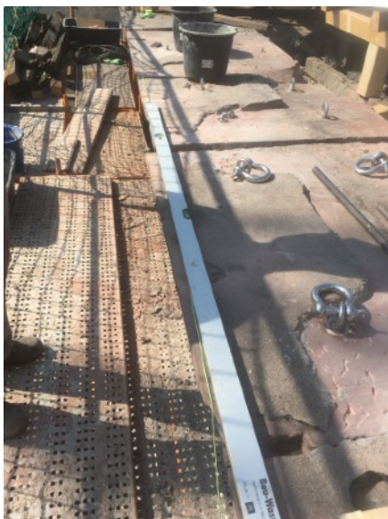
gespannten Schnur - anschliessend Überprüfen der Flucht
