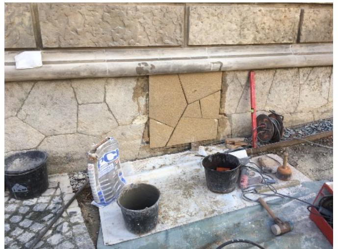
Anpassen der Oberflächenstruktur und des Verlegemusters in der Werkstatt
