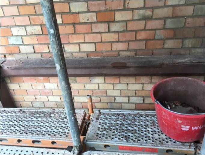
Ergänzung am Gurtgesims der linken Gebäudehälfte und Gesimsanschluß am Postament der Säule
