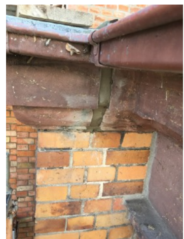
Besonders breite Fugen ohne Füllung vorab mit größerem Trasskalkmörtel vorgrundiert
