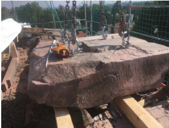
Herausheben des folgenden Gesimsstückes
