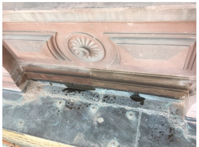
Behandlung stark entfestigter Oberflächen am Gesimsprofil des Traufgesimses der SW Fassade und Fenstersturz im EG rechte Gebäudehälfte.
