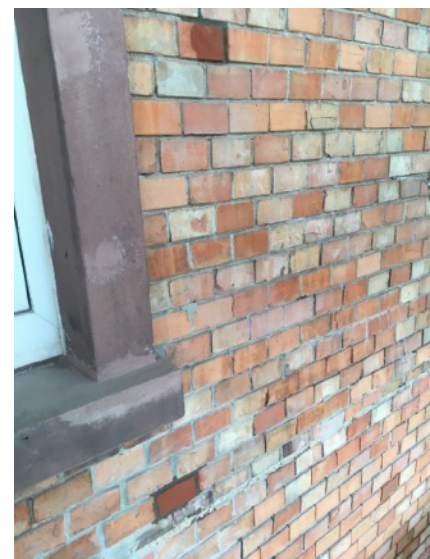
Ergänzungen an der Ecklisene des Nebenflügels und Fassade 2.OG. mit Resturiermörtel
