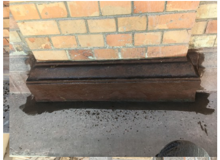
Festigen des Sockelgesimses des 1.OG rechts
