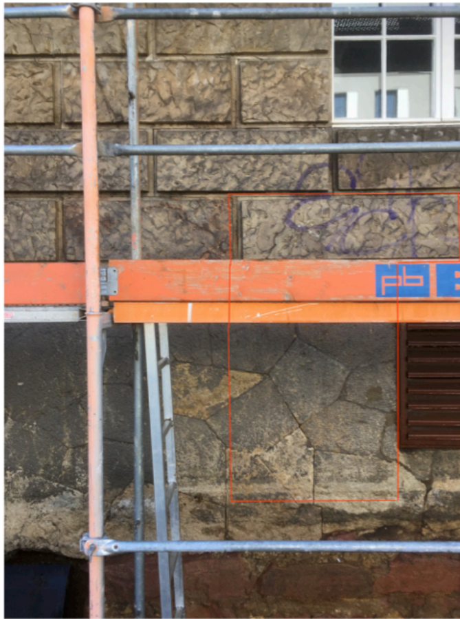
Musterbereich nach Reinigungsstufe 1 und 2
