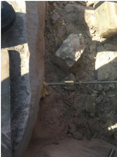
Rückseitiges Einbringen der Bohrungen, Einrichten und Einpressen der Spannstäbe in Verbundmörtel
