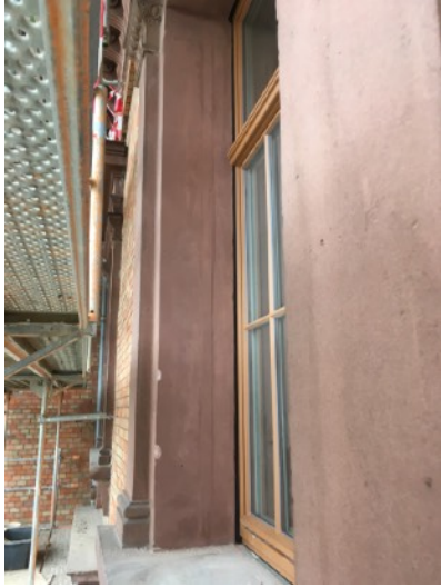
NO-Fassade 2.OG rechte Gebäudehälfte
