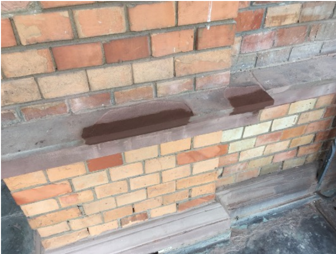
Reprofilierungen an Gurtgesimsen des 1.OG der linken Gebäudehälfte entlang des Risalit
