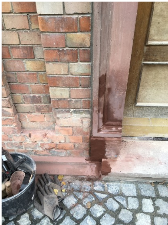
Reprofilierungen am unteren Abschluss der Eingangstürgwände des Nebengebäudes West
