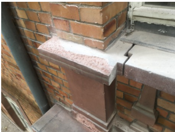
Vorbereiten der Ballustradenabdeckung für Antragung und nach der Reprofilierung
