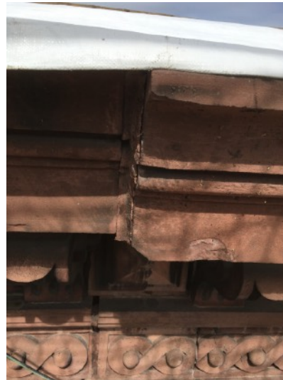
Die mittleren drei Gesimse haben sich bis zu 5 cm nach außenverschoben
