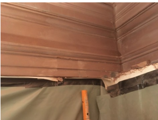
Reprofilierung mit Restauriermörtel
