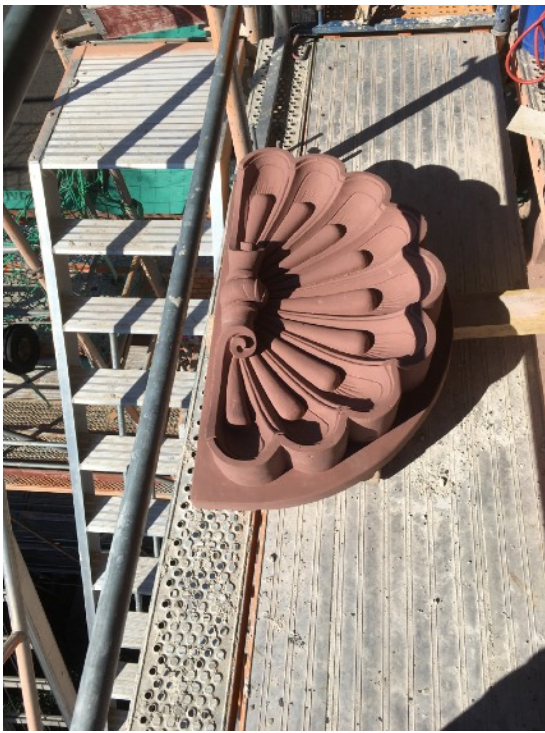
Werkstück auf dem Gerüst an der Einbaustelle kurz vor Einbau und während des Einbaus
