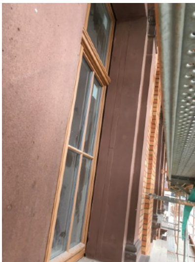
Leibungen der Fensterreihe 1. OG der NW-Fassade. und der NO-Fassade nach Anlage der Lasur
