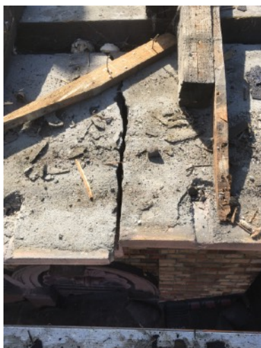
Freilegen der Fugenbereiche um das schonende Herausheben zu sichern
