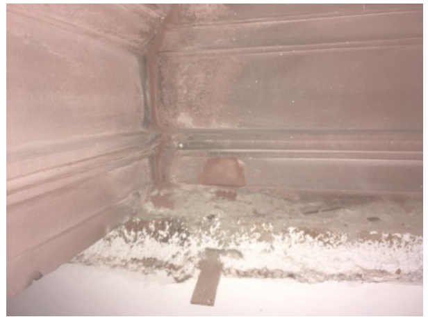
Schliessen offener Fugen mit pigmentiertem Fugenmörtel in den Eckbereichen
