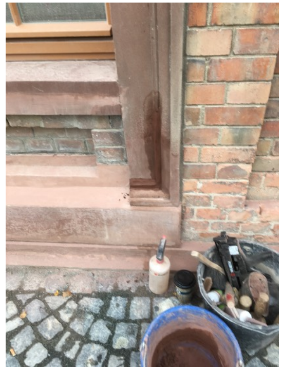
Reprofilierungen am unteren Abschluss der Eingangstürgwände des Nebengebäudes West
