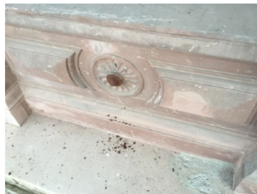
Ergänzte Rosette unterhalb Fensterbank 1.OG
