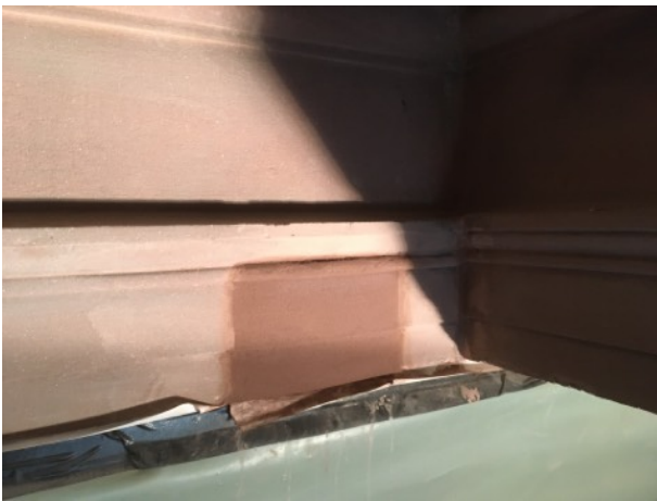
Farbgenaue Antragungen mit Restauriermörtel nach dem Abbinden
