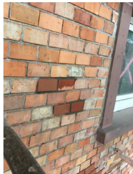
Ergänzungen an der Ecklisene des Nebenflügels und Fassade 2.OG. mit Resturiermörtel
