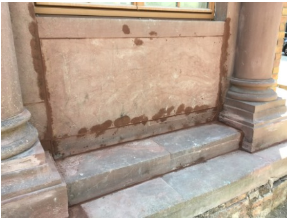
Sandsteinverfugung am Sockelbereich mit pigmentiertem Restauriermörtel
