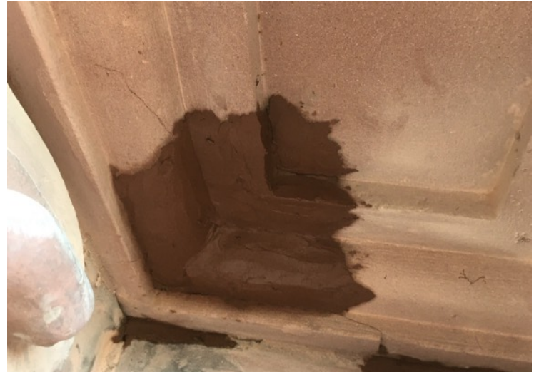
Schliessen einer ehem. Rohrdurchführung im Traufgesims im linken Randbereich der NO-Fassade
