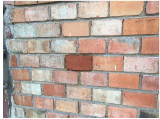
Ergänzungen im Bereich des DG unterhalb des Traufgesimses mit Restauriermörtel
