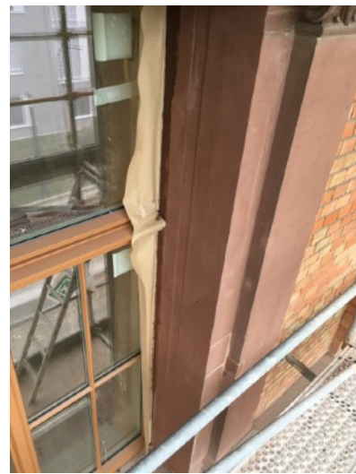
NW-Fassade 2.OG. rechte Gebäudehälfte jeweils nach Anlage der Lasur
