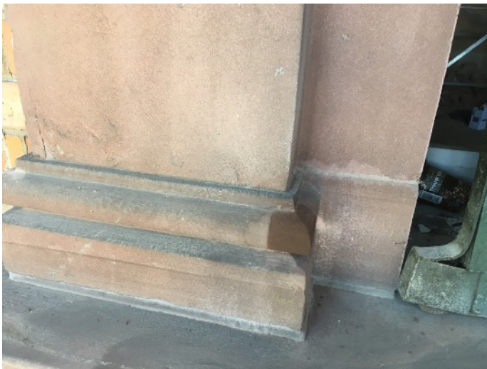
Pilasterbasis des linken Fenstergewands und Sockelprofil des 1. OG des rechten Gebäudeflügels
