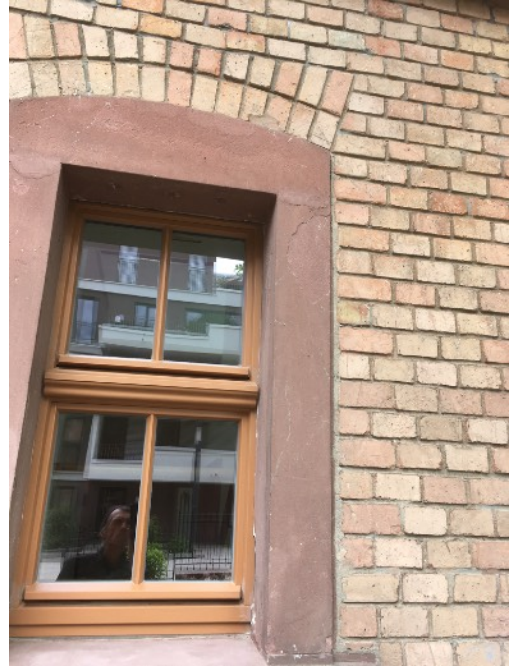
Fenstersturz des EG- Fensters rechts des Hintereingangs vor und nach der Reprofilierung
