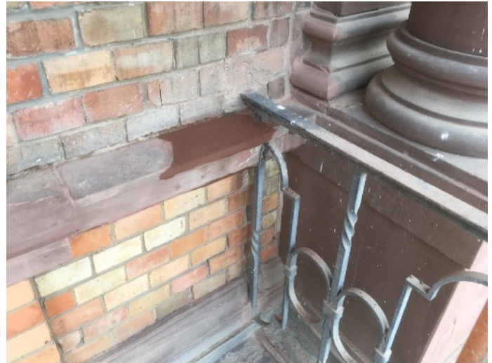
Ergänzung am Gurtgesims der linken Gebäudehälfte und Gesimsanschluß am Postament der Säule
