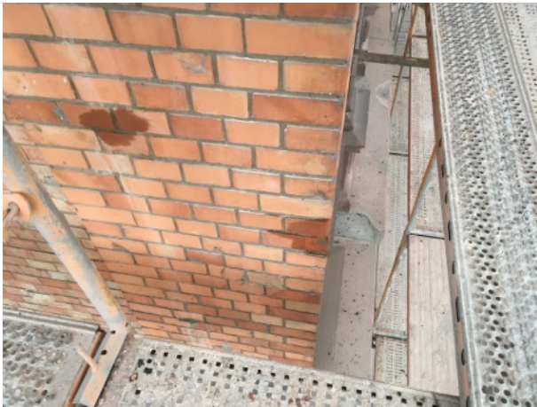
Ergänzung schadhafter Ziegelsteine durch ziegelfarbene Restauriermörtelantragungen
