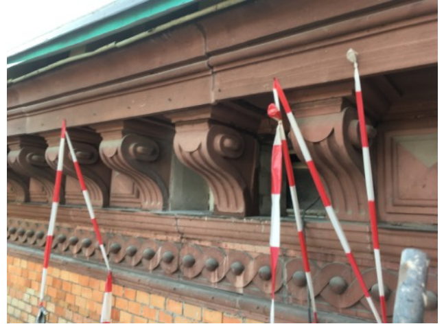
Unterkonstruktion für die zusätzliche Konsole im Bereich des anzupassenden Fensters an der Nord-Ostfassade und nach Einbau.
