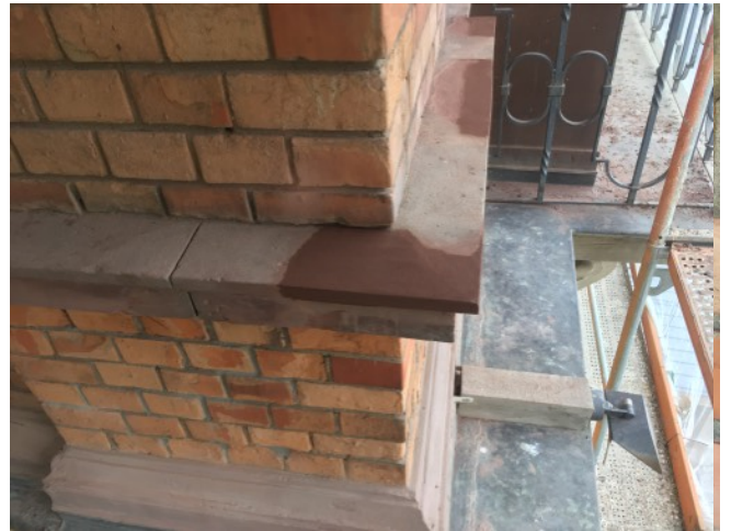
Reprofilierungen an Gurtgesimsen des 1.OG der linken Gebäudehälfte entlang des Risalit
