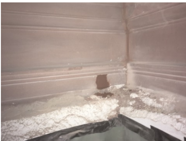
Antragungen mit Restauriermörtel und abgebundene sowie aufgeraute Grundiermörtelantragungen...
