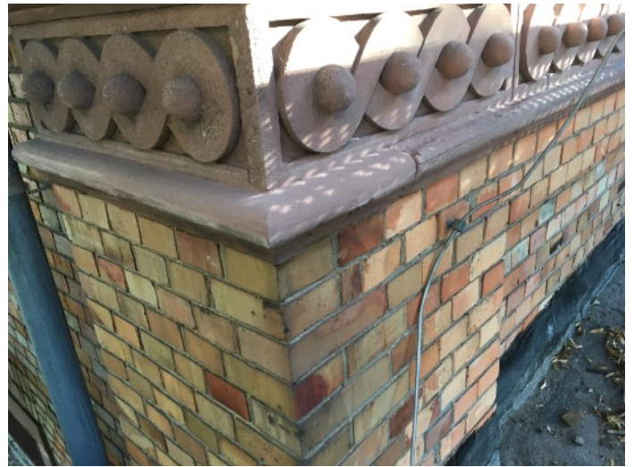
Wiederkehr unterer Abschluß des Traufgesims (SO-/SW-Fassade)
