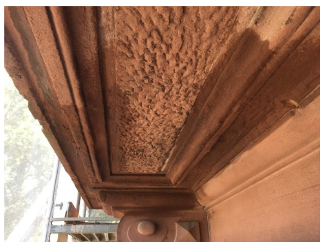
Festigung an der Unterseite des Balkons
