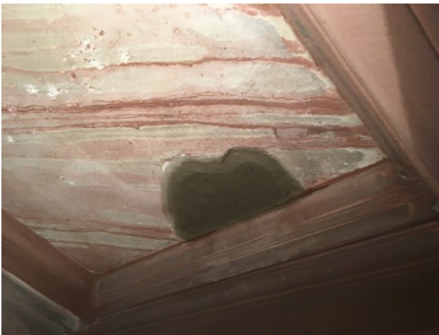
Vorbereiten des Feinmörtelantrags (marmoriert)
