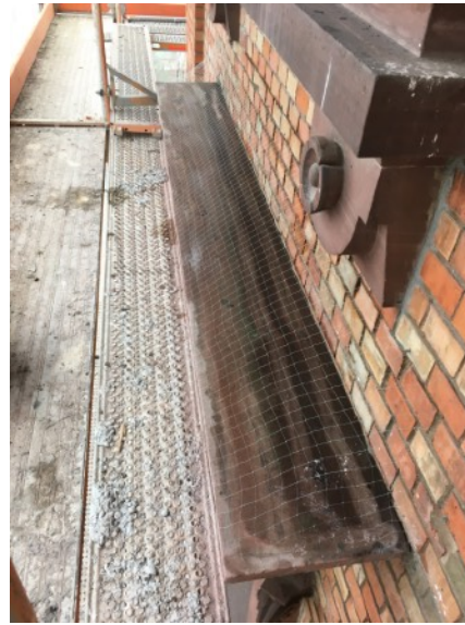
Fenstersturzesimse im 1.OG der NW-Fassade mit in vorgesehene Ösen gespannte Netze...
