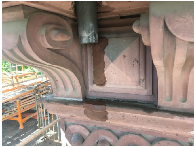
Ergänzung am linken Diamantblock unterhalb des Traufgesimses
