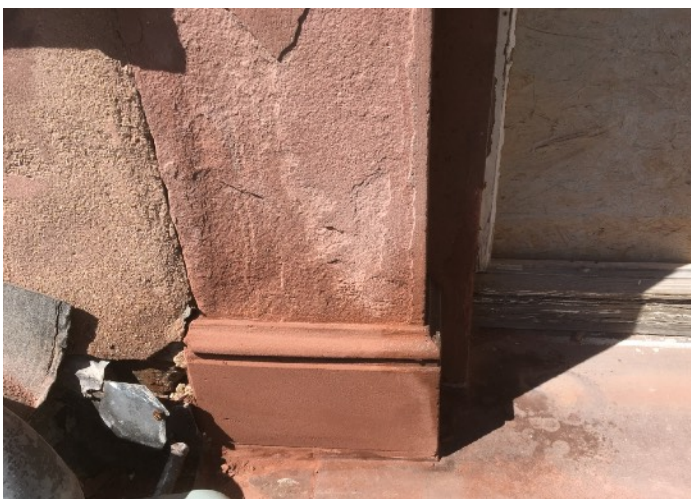
Fenster des Turms (3. OG)
