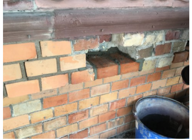
Ersetzen von flächig eingebauten fehlerhaften Ziegelsteinen durch passende unterhalb des Traufgesims (3.OG Fassadenmitte)
