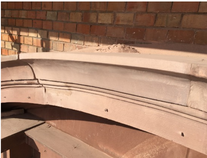
Segmentbogenprofil des Risalt
