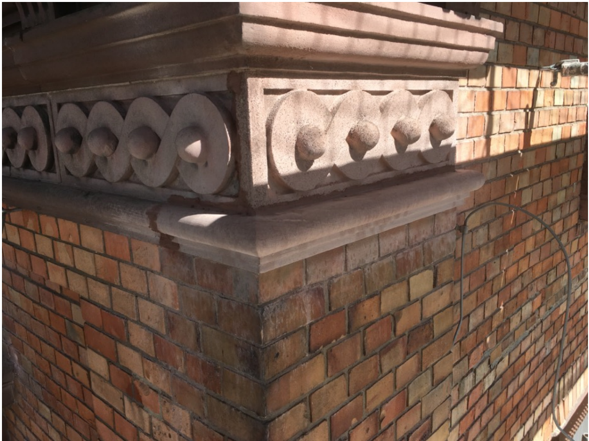
Profiliertes Gesimsstück der Ecklisene der SW/SO Fassade
