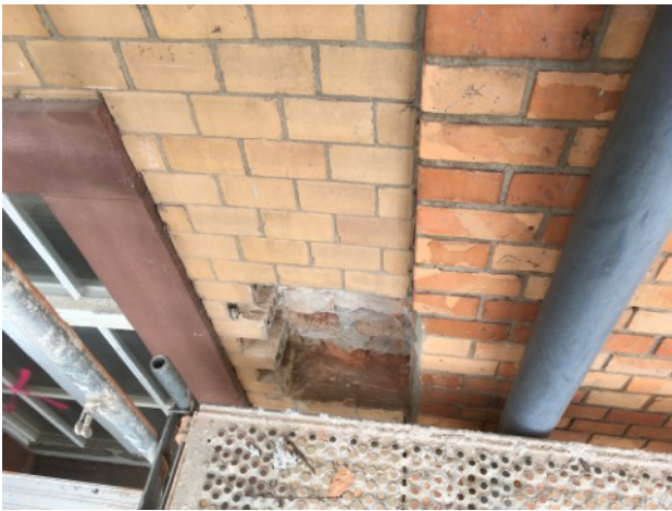
Nordwestfassade Erweiterungsbau des linken Gebäudeflügels - Ersetzen unpassender Mauersteine durch passende Ziegel im Reichsformat von 1879
