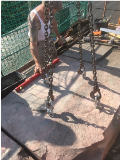
Vorsichtiges Herausheben des ersten Gesimsstückes und auf vorbereitete Kanthölzer über der Lagerfläche ablegen und an den Haken belassen zwecks zusätzlicher Absicherung.
