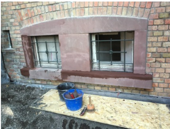
Doppelfenster Sockelgeschoß unterhalb des Treppenhauses während und nach den Rrprofilierungsarbeiten
