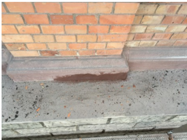
Sandsteinsockelprofil der Lisene
