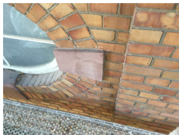
Kämpferstein am Rundfenster des 1. OG. vor und nach der Reprofilierung
