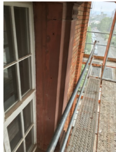
Nach Anlage der Sandsteinlasur
