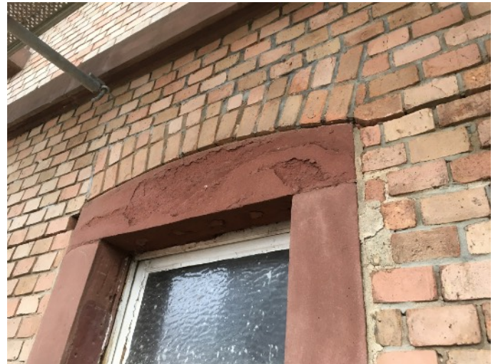
Behandlung stark entfestigter Oberflächen am Gesimsprofil des Traufgesimses der SW Fassade und Fenstersturz im EG rechte Gebäudehälfte.
