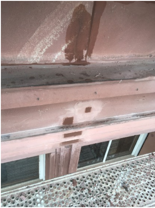
Antragungen am Sturz des Tür des Balkons 2.OG
