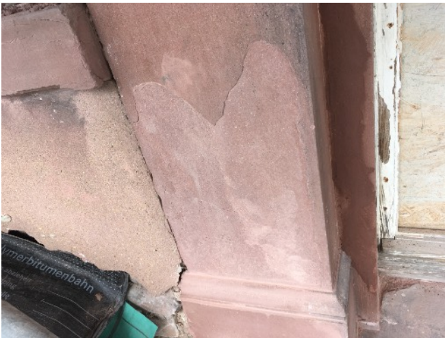
Schalenbildung am Gewand 3.OG des Turms und Einsatz von Anböschmörtel auf KSE-Basis
