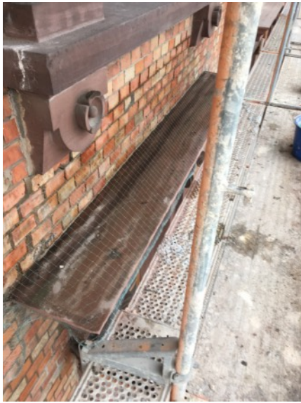
Fenstersturzesimse im 1.OG der NW-Fassade mit in vorgesehene Ösen gespannte Netze...
