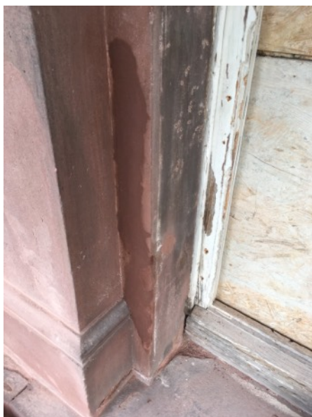
Schalenbildung am Gewand 3.OG des Turms und Einsatz von Anböschmörtel auf KSE-Basis
