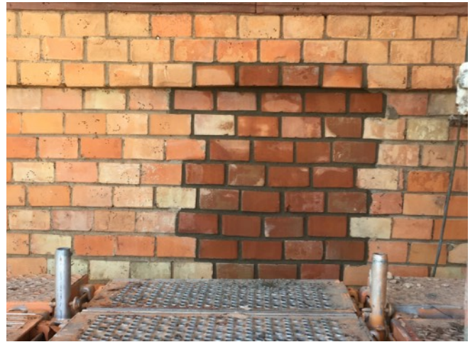
passende Mauerwerkssteine im Reichsformat Nordwestfassade 2. OG linke Gebäudehälfte
