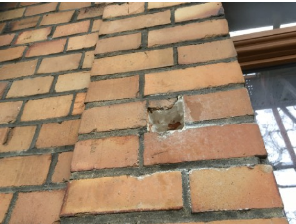
Fugenerneuerung und Schliessen von Lücken innerhalb des Ziegelmauerwerks der SW-Fassade
