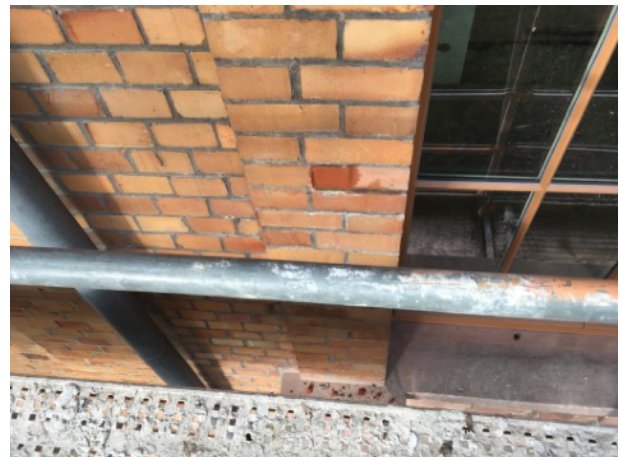
Fugenerneuerung und Schliessen von Lücken innerhalb des Ziegelmauerwerks der SW-Fassade
