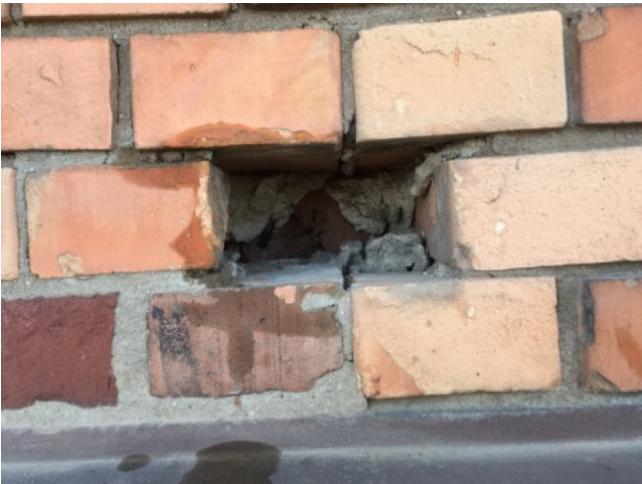
Ergänzen einzelner zahlreicher Ziegel im Reichsformat
