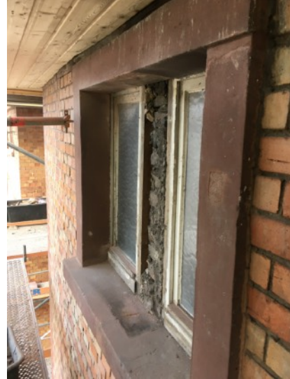
Ausbau des Mittelpostens zur Angleichung der Fensterformate im 3. OG. SW-Fassade
