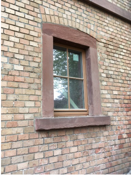
Fenstersturz des EG- Fensters rechts des Hintereingangs vor und nach der Reprofilierung
