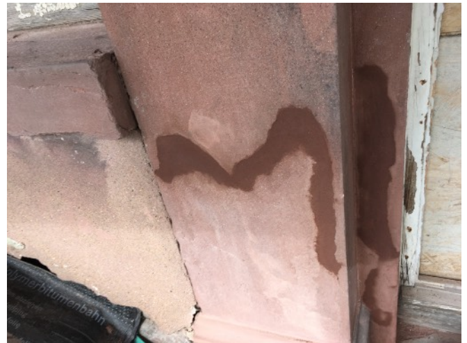
Schalenbildung am Gewand 3.OG des Turms und Einsatz von Anböschmörtel auf KSE-Basis
