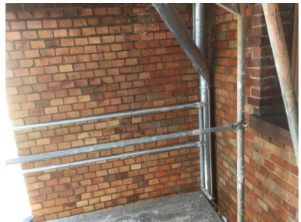
Zweischaliges Schliessen einer Mauerwerksöffnung im Bereich des Fahrstuhls 3. OG SW-Fassade
