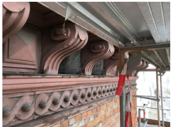
Im Traufbereich integrierte Fensternischen des 3. OG der NO- und NW-Fassade - aufgrund der starken Schattierung wurden hier dunkle Netze verwendet. Die Spannösen mussten neu installiert werden
