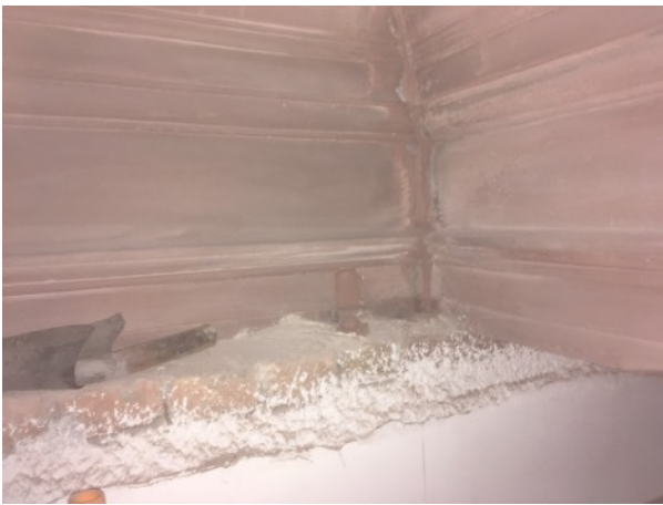
Schliessen offener Fugen mit pigmentiertem Fugenmörtel in den Eckbereichen
