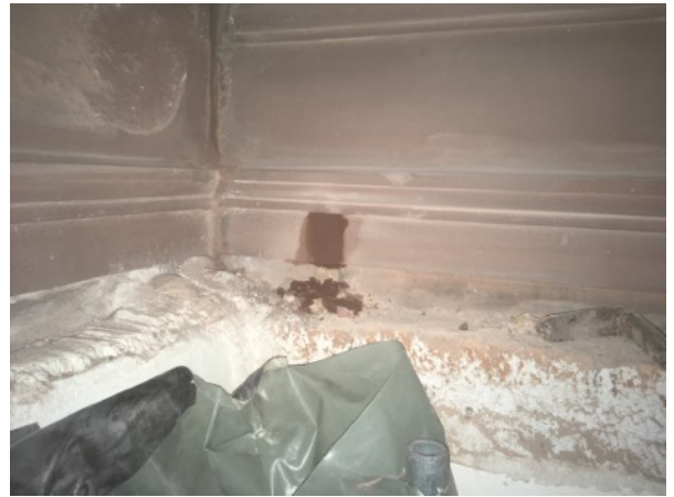
Antragungen an kleineren Fehlstellen
