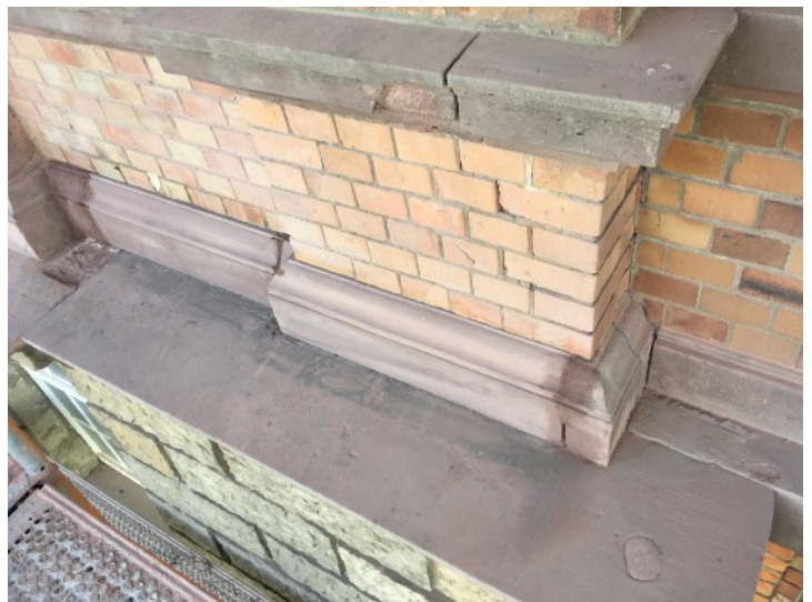
Sockelgesimsstück nach Reprofilierung
