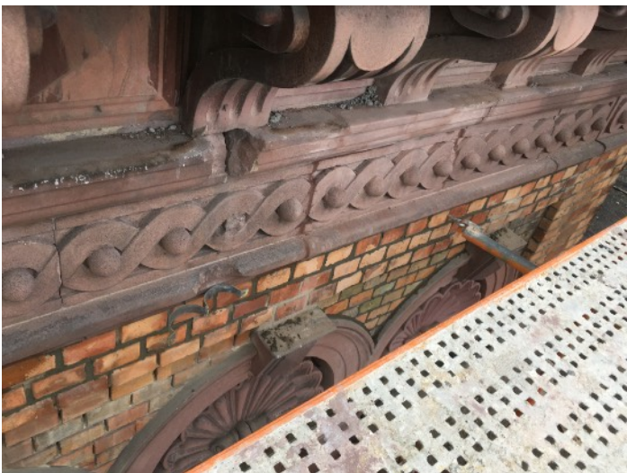
Gesims Fenstersturz 2.OG. links
