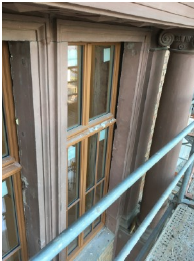
Leibungen der Fensteröffnung und Säulen des Balkons im 1. OG der NO Fassade Die Säule wurde nur partiell lasiert, um eine intakte ältere Anstrichung anzupassen
