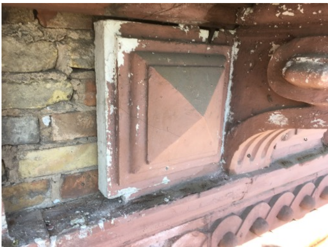
Beschädigte und verwitterte Konsolen vor dem Rückbau
