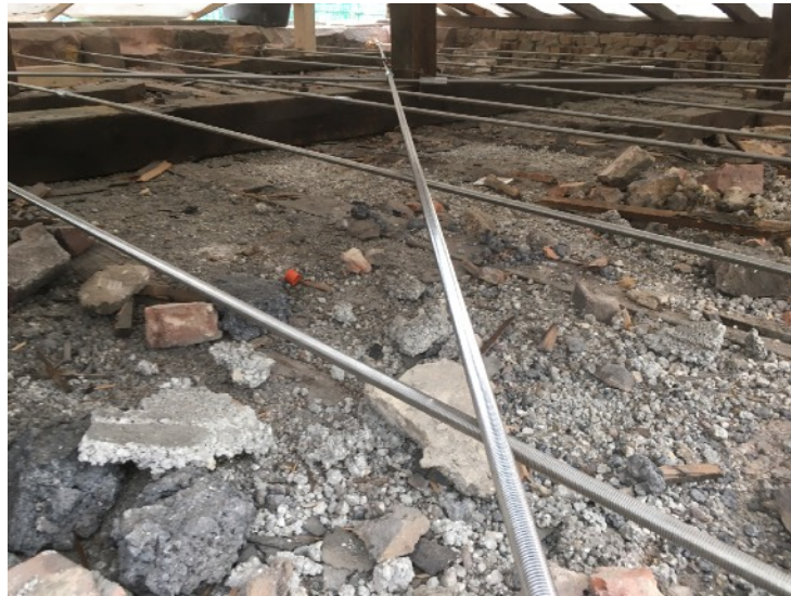
Zuganker orthogonal und diagonal nach Abschluss der Sicherungsarbeiten am Traufgesims des Turms
