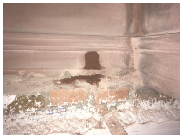
Vorbereitung für die Ergänzung grösserer Fehlstellen mit Grundiermörtel anschliessend Restauriermörtelantrag
