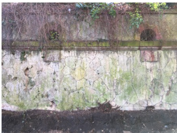
Einfriedungs- bzw. Stützmauer aus Jurakalkstein zum Park an der Nordost-Seite des Grundstücks mit starkem biogenen Befall und Verkrustungen
