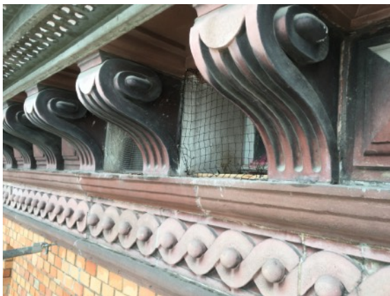
Im Traufbereich integrierte Fensternischen des 3. OG der NO- und NW-Fassade - aufgrund der starken Schattierung wurden hier dunkle Netze verwendet. Die Spannösen mussten neu installiert werden
