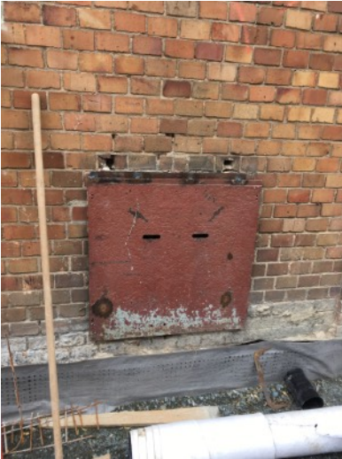
Ausbau der Eisenklappe und Schliessen der entstandenen Öffnung mit RF-Ziegelsteinen
