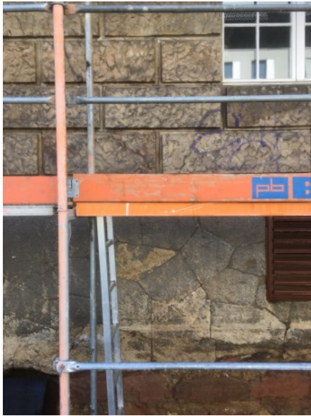
Musterfläche vor Reinigung im IOS- Verfahren
