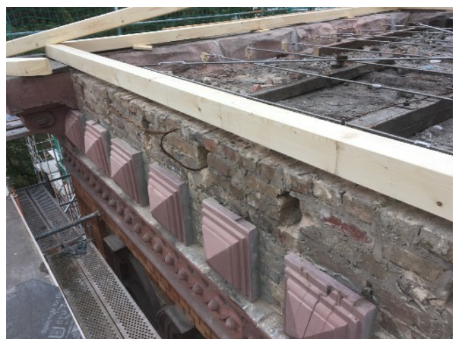
Nach dem Einbau der Diamantblöcke
