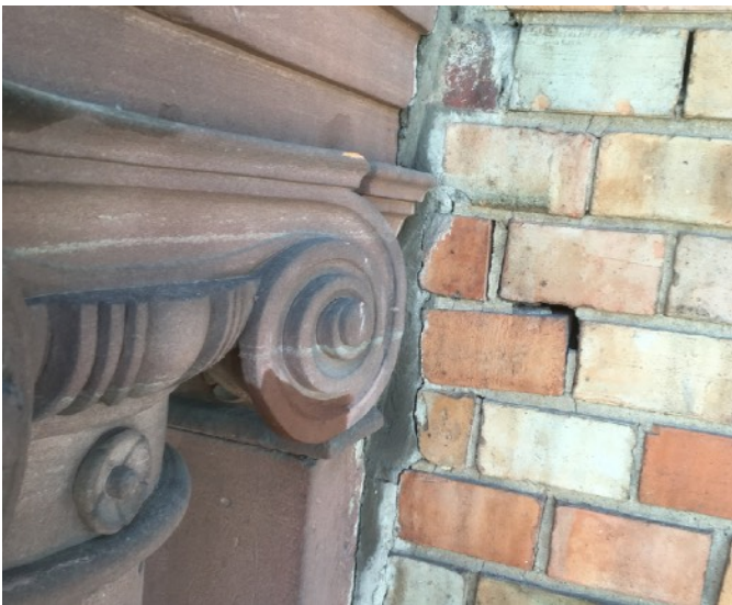
Reprofilierungen am Kapitell rechts unterhalb des Balkons 2. OG
