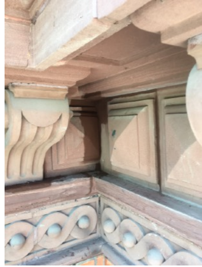
Reprofilierungen an Diamantblöcken unterhalb des Traufgesims
