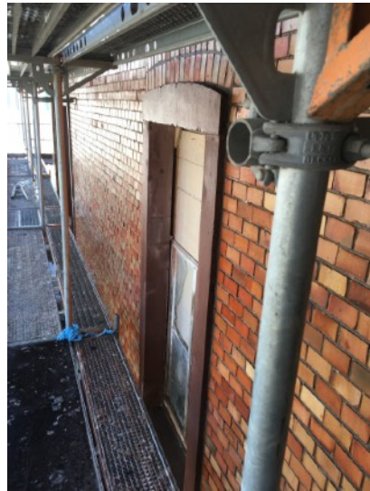
Südwestfassade - Ziegelmauerwerk und Sandstein mit biogener Verschmutzung - Reinigung mit Bürste unter sanftem Wasserstrahl
