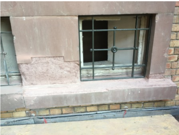
Doppelfenster Sockelgeschoß unterhalb des Treppenhauses während und nach den Rrprofilierungsarbeiten
