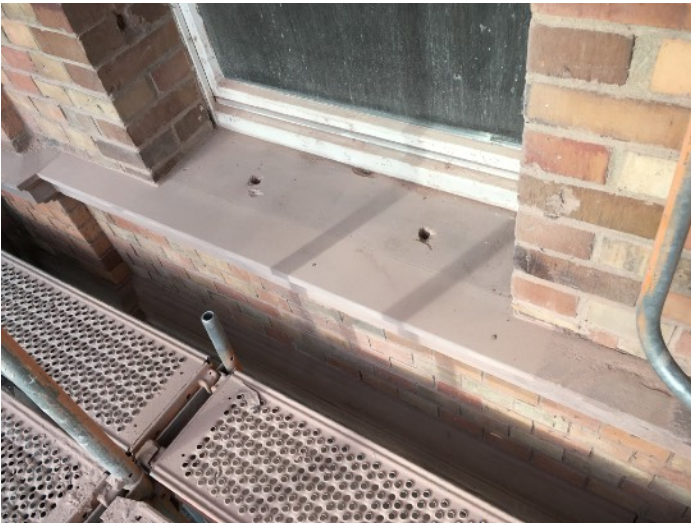
Fenstergesims 1. OG linke Gebäudehälfte
