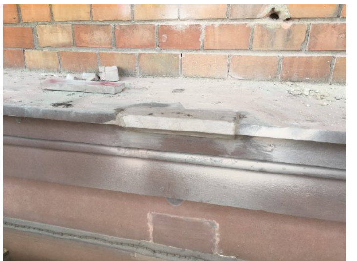
Sockelgesimsstück nach Reprofilierung
