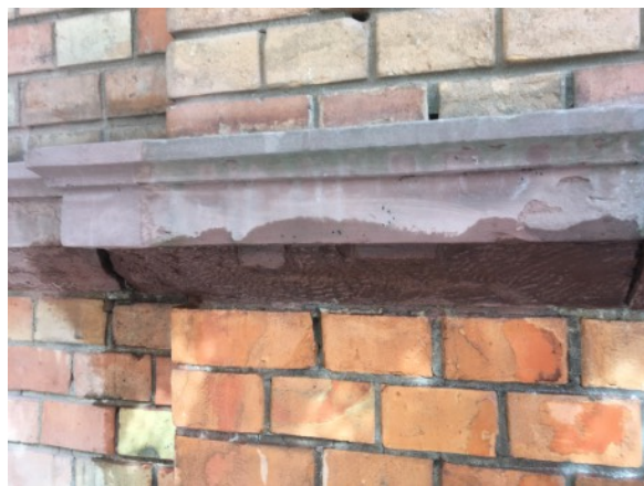
Ergänzung an der Unterkante und Oberkante des Gurtgesimses 1. OG
