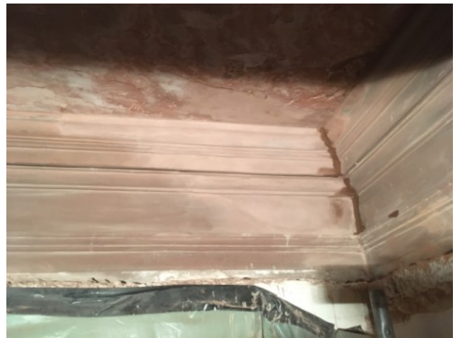
Nach dem Abbinden und Schliff
