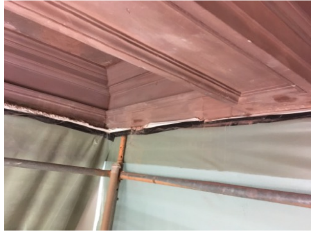
Anlegen von Lasuren zur optischen Beruhigung der Sandsteinoberflächen
