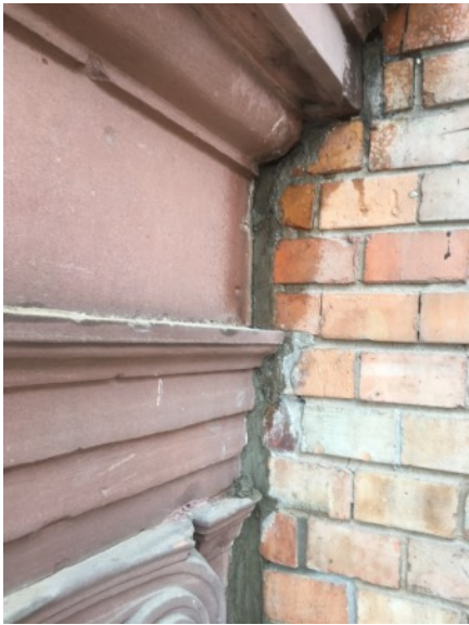
Anschlußfugen zum Ziegelmauerwerk wurden mit Trasskalk -Fugenmörtel ergänzt
