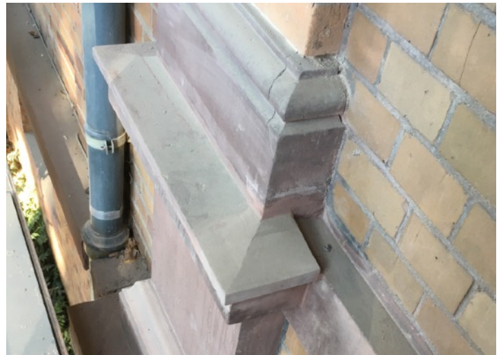
Wiederkehr unterer Abschluß des Traufgesims (SO-/SW-Fassade)
