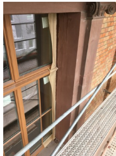
Leibungen der Fensterreihe 1. OG der NW-Fassade. und der NO-Fassade nach Anlage der Lasur
