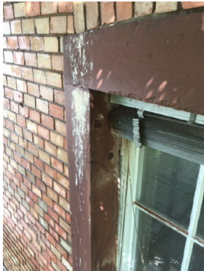
Südwestfassade - Ziegelmauerwerk und Sandstein mit biogener Verschmutzung - Reinigung mit Bürste unter sanftem Wasserstrahl
