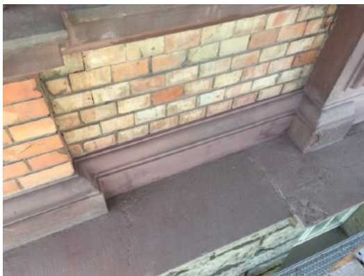
Sockelgesims des 1. OG.
