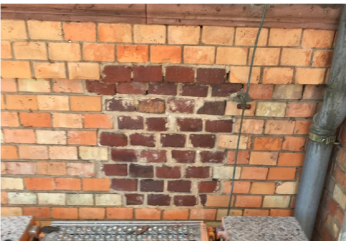
Entfernen sowohl schadhafter als auch unpassender Ziegelmauerwerksfläche und Ersetzen durch
