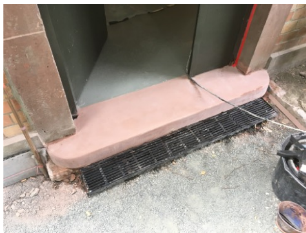
Restaurierte Türschwelle mit 2 komponentigem Restauriermörtel (Epasit)
