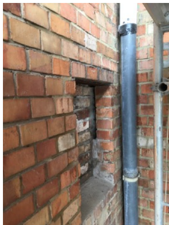
Zweischaliges Schliessen einer Mauerwerksöffnung im Bereich des Fahrstuhls 3. OG SW-Fassade
