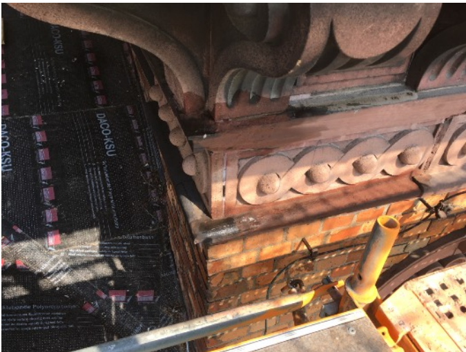
Behandlung stark entfestigter Oberflächen am Gesimsprofil des Traufgesimses der SW Fassade und Fenstersturz im EG rechte Gebäudehälfte.
