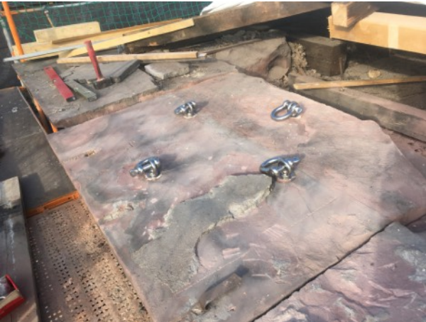
Das erste Gesimsstück ist für das Herausheben vorbereitet
