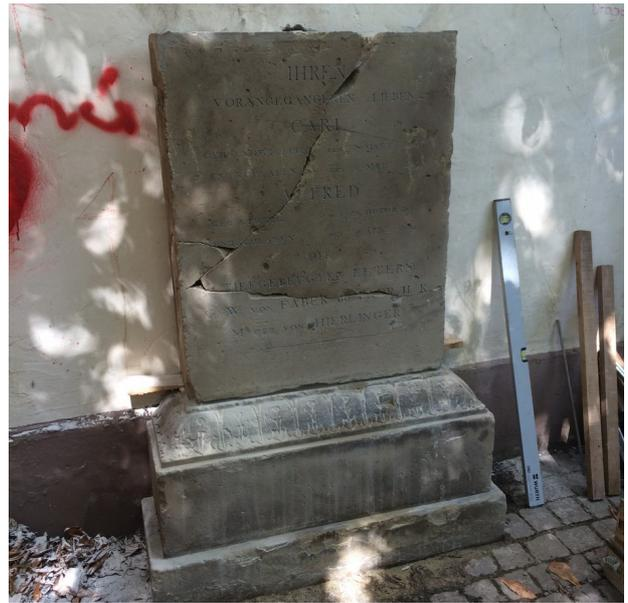
Nach dem Zusammenfügen des Mittelstücks wurde das Epitaph durch Einbau einer Edelstahlklammer (V4A Bandstahl 20 x 5 mm) mit der rückwärtigen Gebäudewand verbunden und befestigt und damit nochmals zusätzlich stabilisiert. Die Klammer wurde zu beiden Seiten mit Verbundmörtel eingesetzt. Entsprechende Bohrungen mussten zuvor hergestellt werden.
