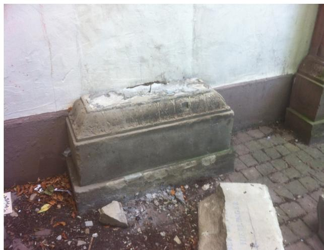
Vorhandene unterdimensionierte Eisenstifte (korrodierte Zimmermanns-Nägel) als Verankerung in Sockel und der oberen Fügungsfläche der Schrifttafel des Epitaphs, sowie spröde Zementmörtelreste auf den Standflächen.
