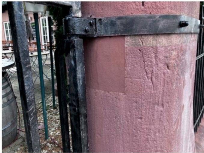
Restaurierung und Konsolidierung der Torpfosten aus Sandstein (Pos. I.8) einschl. Schlosserarbeiten
