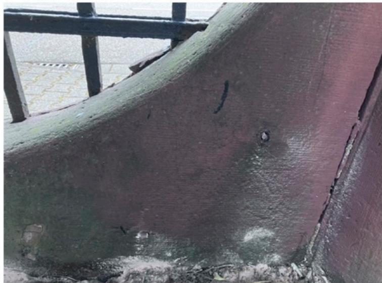
Freilegen korrodierter in den Sandsteinsockel eingebundener Zaunstäbe und Verpressen der Risse (Pos. I.4)
